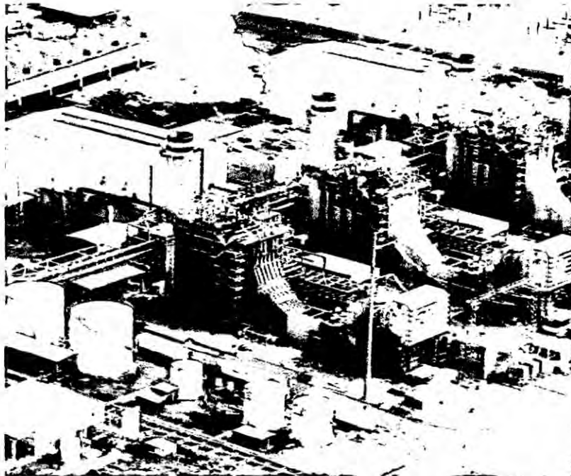
Figura 2. Central térmica de ciclo combinado.
