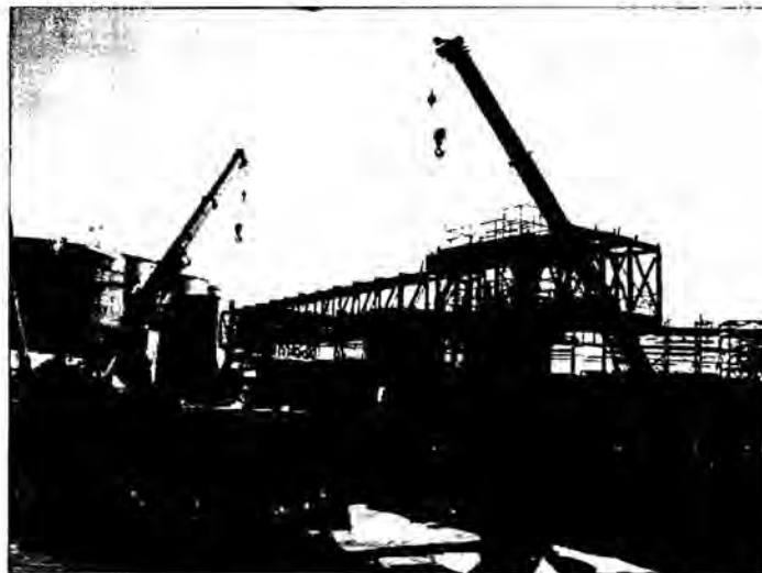
Figura N°16. Ubicación de grúas para el Montaje del Puente del Espesador
