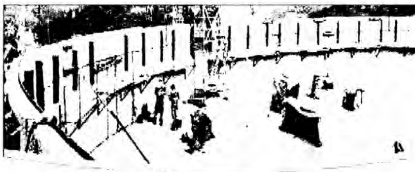
Figura N°21. Armado de anillos del Espesador
