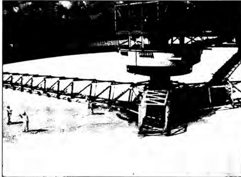
Figura N°48. Pintura de Acabado del Interior del Espesador
