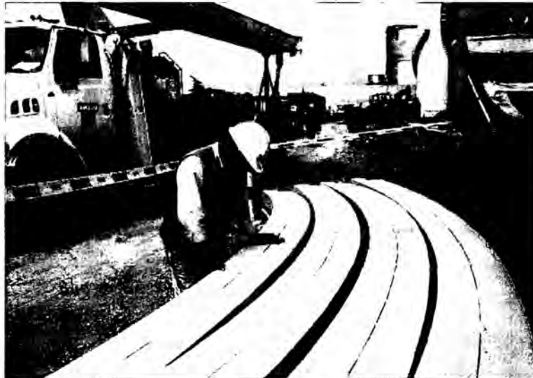
Figura N°23. Verificación de la curvatura del Anillo de Rigidez del Espesador
