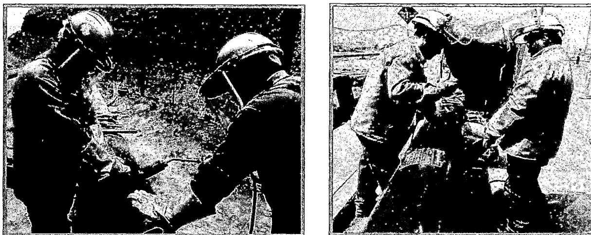
FIGURA N° 4.15 COLOCACIÓN DE LA MANTA TERMO CONTRAÍBLE
