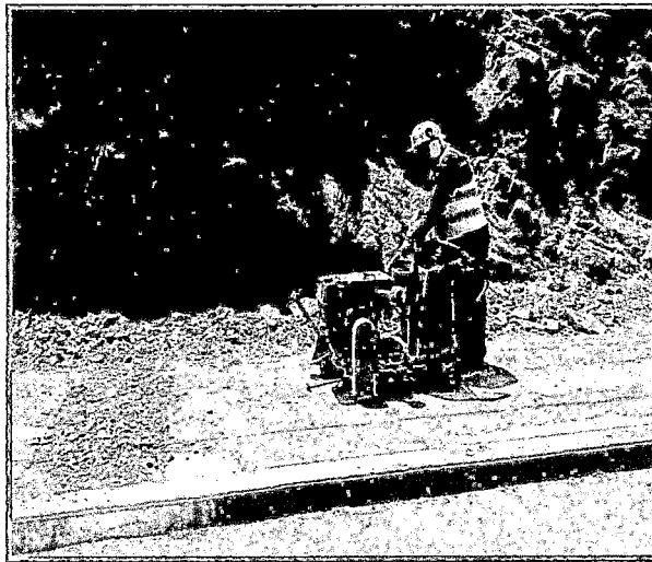
FIGURA N°4.2 CORTE DE PAVIMENTO
