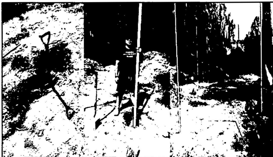
**Fotografía 3:** Instalación de las bases del sistema de recubrimiento compuesto de 6 maderas enterradas a 30 cm de profundidad.
