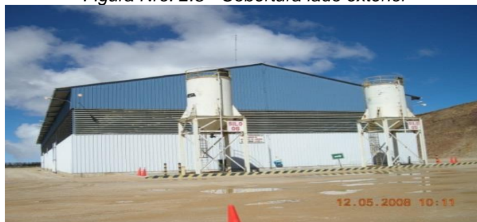
Figura Nro. 2.8 - Cobertura lado exterior
