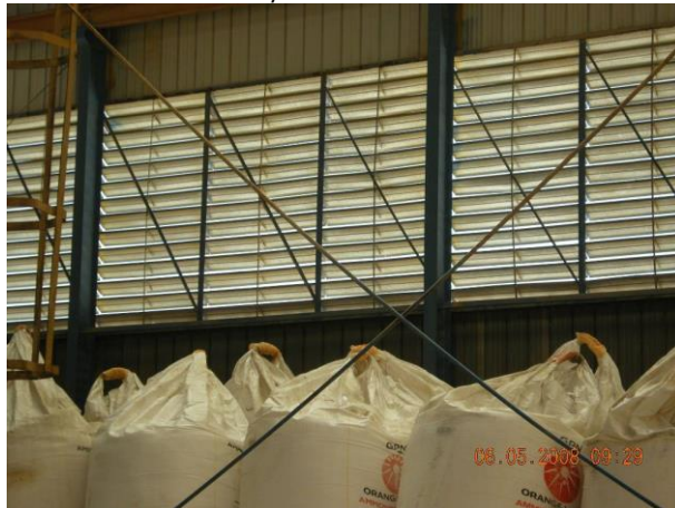
Figura Nro. 4.2 – Uso de fierro liso redondo \varnothing 3/4 " usado como arriostre entre columnas
