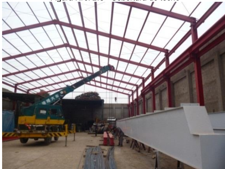
Figura Nro. 2.6 - Cobertura de techo
