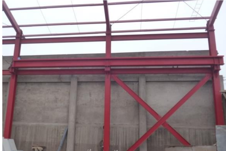
Figura Nro. 2.5 Arriostramiento entre columnas
