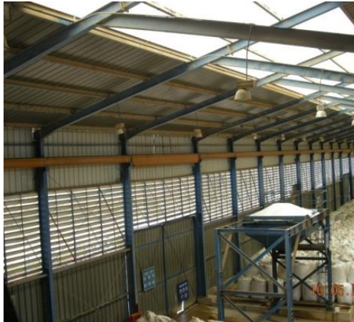
Figura Nro. 2.3 - Columnas de una nave industrial
