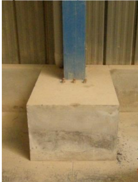
Figura Nro. 2.2 - Zapata de concreto
