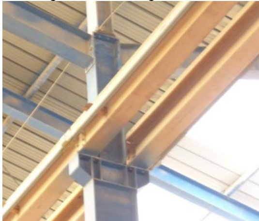
Figura Nro. 2.4 - Vigas carrileras
