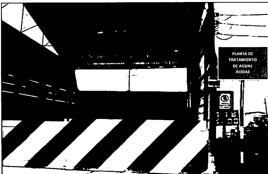
Figura 10.9: Vista frontal de la Planta de Tratamiento de Aguas Ácidas
