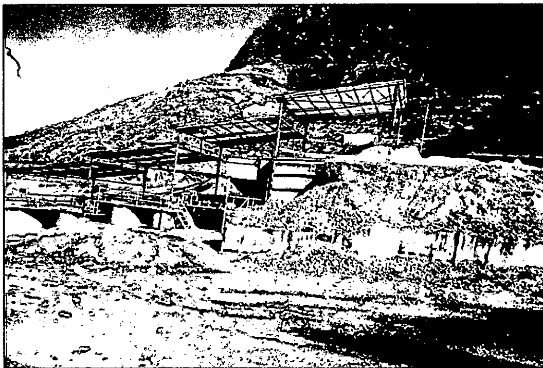
Figura 10.10: Vista lateral de la Planta de Tratamiento de Aguas Ácidas
