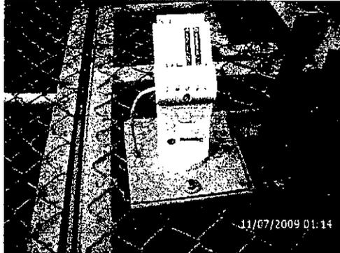
Figura 780: Sensores ultrasónicos de nivel
