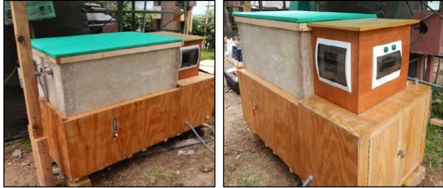
FIGURA 2.15 VISTAS DEL SISTEMA DE TRATAMIENTO COMPACTO DE LODOS ACTIVADOS DEL TIPO SECUENCIAL
