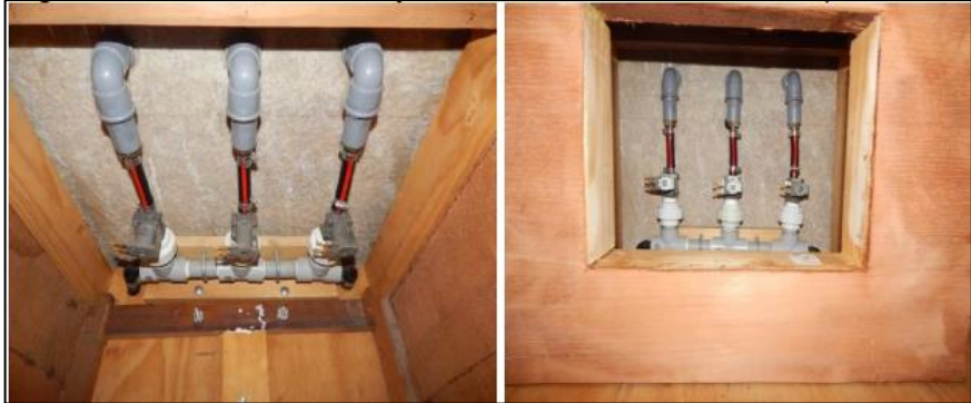
FIGURA 2.9 VISTAS DE VÁLVULAS DE SOLENOIDES PARA EL AIRE
