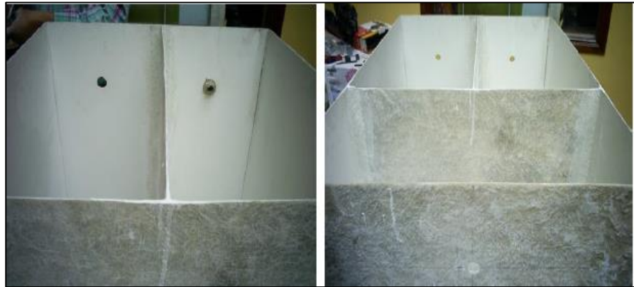
FIGURA 2.3 VISTAS DE LA CONSTRUCCIÓN DEL EL SISTEMA DE TRATAMIENTO COMPACTO DE LODOS ACTIVADOS SECUENCIALES
