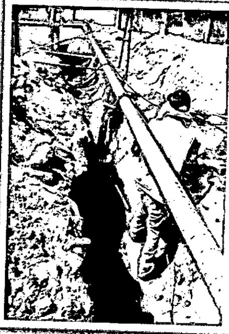
4) SE PRESURIZO CON NITROGENO A LA LINE A DE BAJA PRESION Y SE PROCEDIO A LIMPIAR LA TUBERIA DE LA OXIDACION
