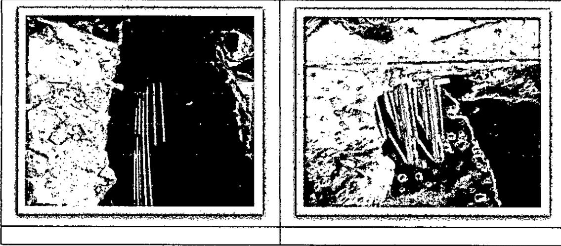
5.-CAMBIO DE TUBERIA DE PVC POR CONDUIT PESADA EN EL BUZON
