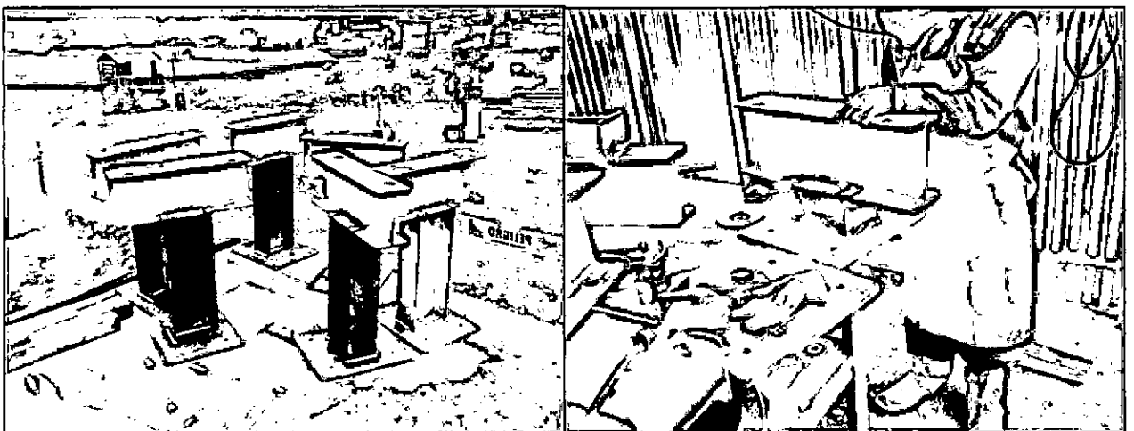
Fig. N° 36.-Fabricación de soportes estructural en general– Fuente propia
