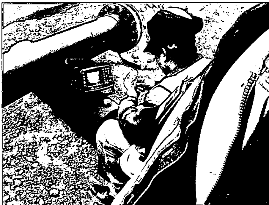
Fig. N° 44.-Ensayos de Ultrasonidos en tuberías HDPE– Fuente propia
