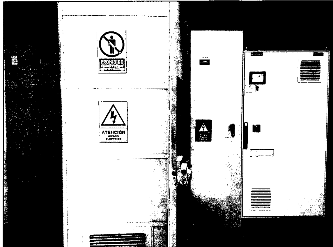
FIGURA N°4.104. FILTRO ACTIVO ACCUSINE INSTALADO EN S.E. N°2.
