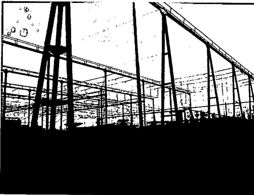
Pórticos de la Subestación en el lado de Alta Tensión
