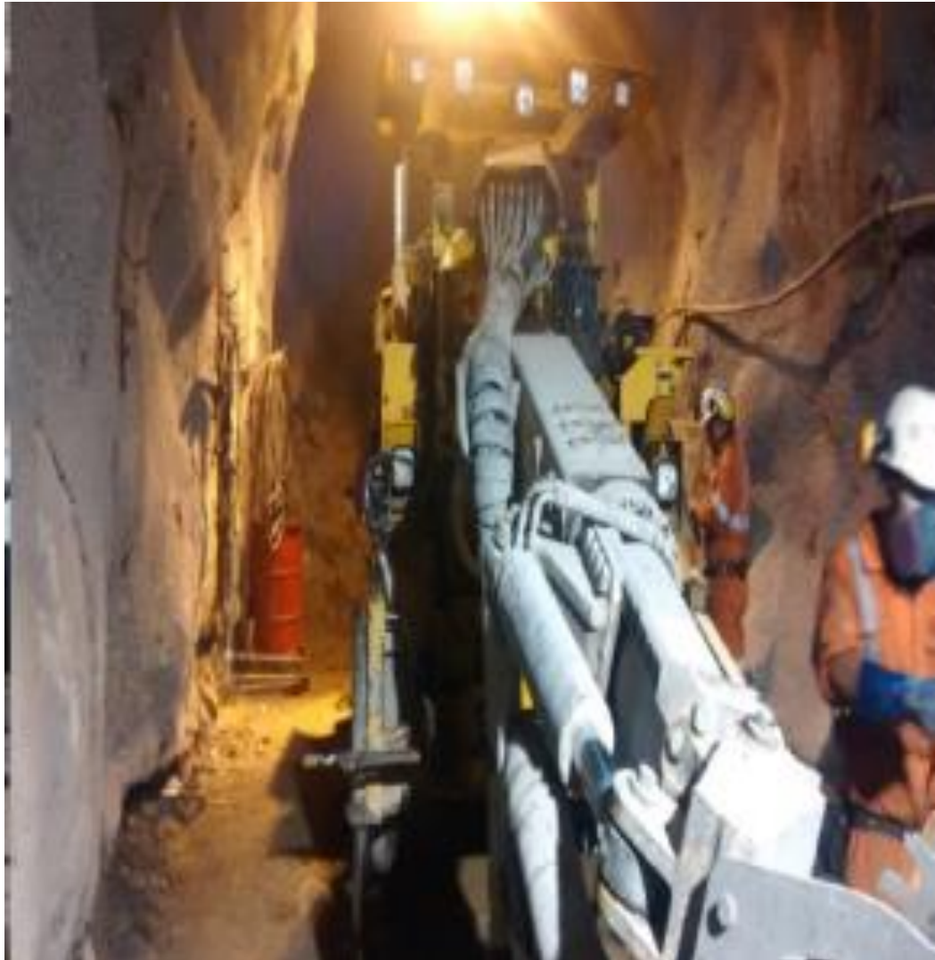
Foto N°3.10: Zonas de inspección de equipos en interior mina Rp. 616
