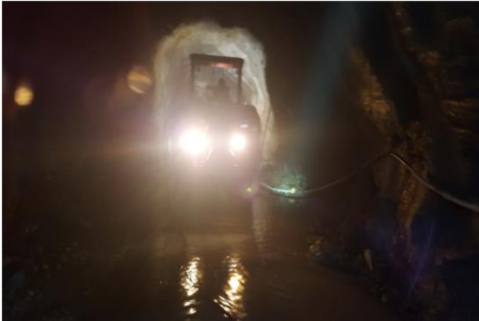
Foto N°3.3: Jumbo en labor interior mina con abundancia de agua
