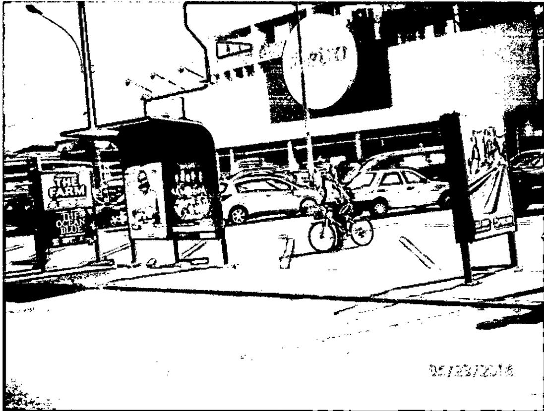
El paradero publicitario está formado ensamblado integralmente de fierro (tubos, ángulos, platinas, planchas, soldadura, pernos)
