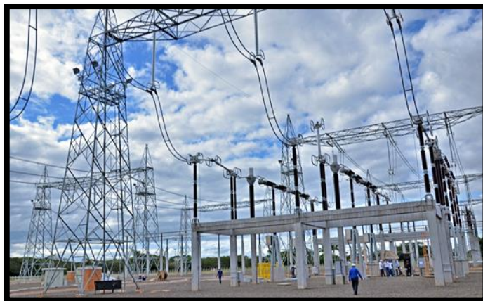
Figura N° 9 Subestación reductora
