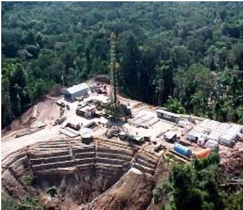
Construcción de plataforma petrolera
