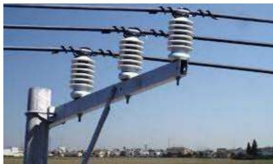
Figura N° 2 Conductor ecológico en red con configuración convencional
