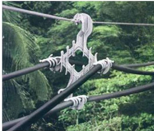
Figura N° 1 Conductor ecológico en red con configuración compacta
