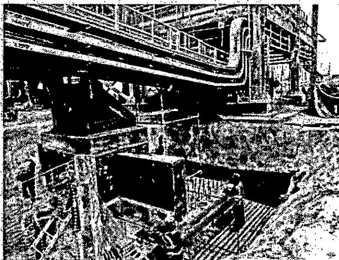
Colocación de puntas acero con capuchones en la parte superior de zapata 2.
