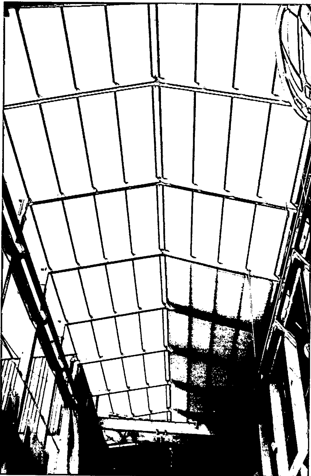
Figura Nro. 4.34. Montaje de cobertura de techo: Se realiza por arriba.
