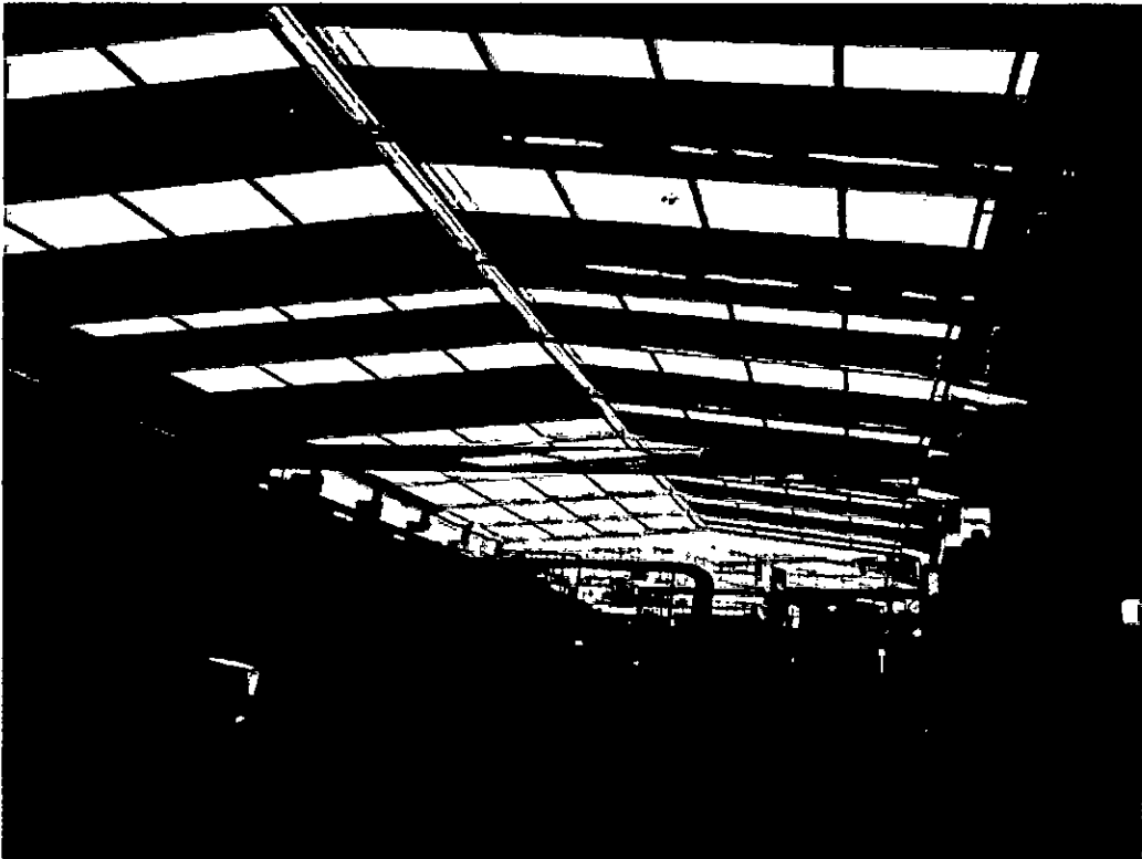
Instalación de cobertura de techo entre ejes 1 y 11: Se deja el espacio para instalación de panel traslucido
