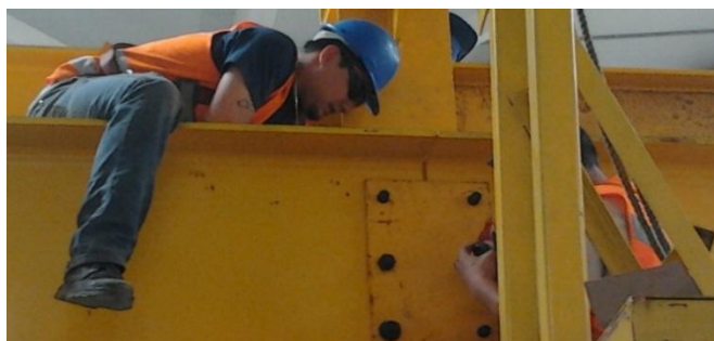
FIGURA N° 49: IZAJE Y UNIÓN POR PERNOS DE LA ESTRUCTURA
