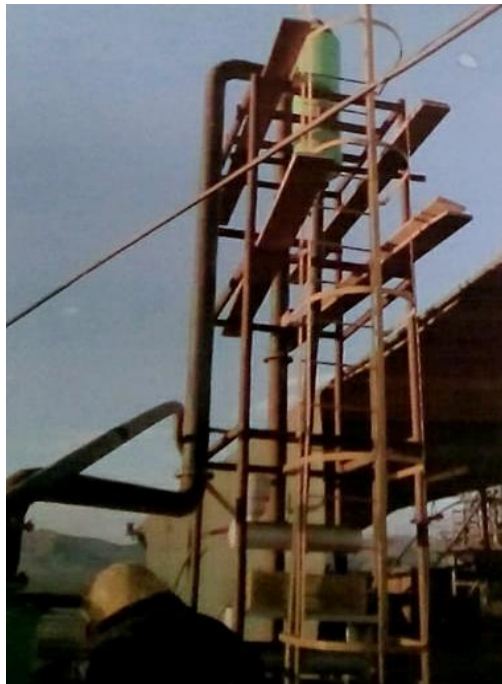
FIGURA N° 50: MONTAJE DE TANQUE TRAMPA DE HUMEDAD Y TUBERÍAS
