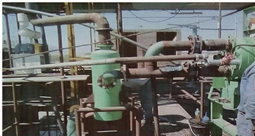
FIGURA N° 51: MONTAJE DE TANQUE RECEPTOR DE VACÍO Y TUBERÍAS
