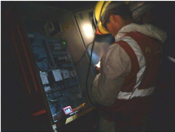
**Figura 5.3** *Medición de parámetros del tablero eléctrico, utilizando la pinza amperimétrica y un megómetro.*
