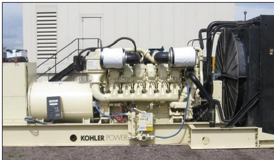
FIGURA 79. GRUPO ELECTRÓGENO KOHLER MODELO 1000ROZD71 – 1250 KVA
