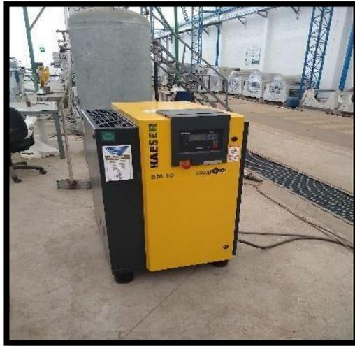
*Figura 2.18.* Compresora de tornillo y tanque pulmón.
