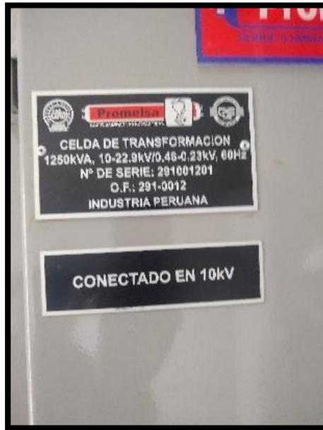
*Figura 2.22.* Transformador de media tensión.
