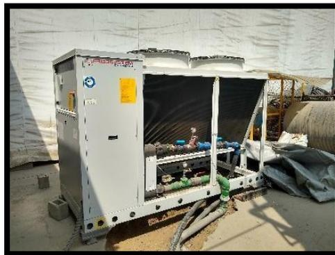
*Figura 2.11.* Unidad enfriadora de agua (Chiller).
