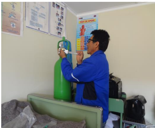
Brindando soporte técnico en Topico Emergencia instalación de manometro
