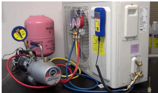
FIGURA 24: PROCESO DE VACÍO Y RECARGA DE GAS
