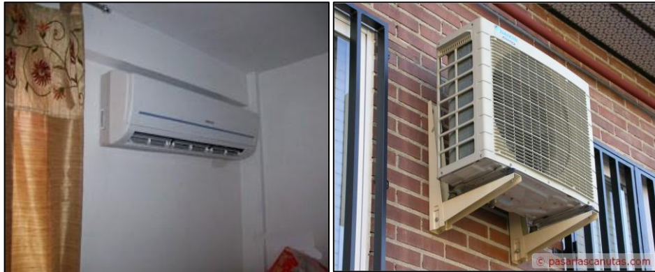
Figura 07: EQUIPO DE AA. TIPO PARED
