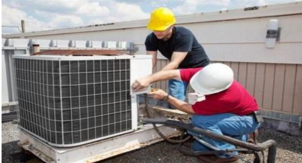
FIGURA 19: INSTALACIÓN DE UNIDAD CONDENSADORA
