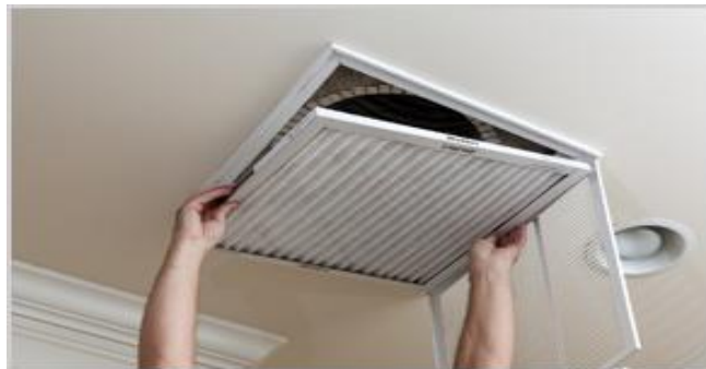
FIGURA 22: INSTALACIÓN DE DUCTOS
