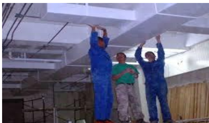
FIGURA 21: INSTALACIÓN DE DUCTOS
