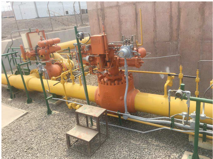
FIGURA 13: VÁLVULA DE BLOQUEO AUTOMÁTICO
