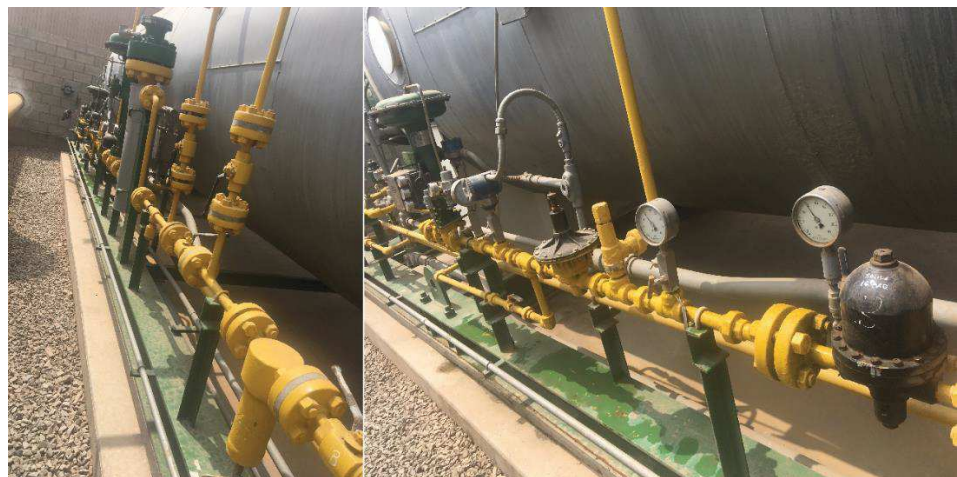
FIGURA 29: TREN DE ALIMENTACIÓN DE GAS HACIA EL CALENTADOR
