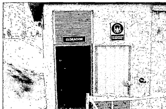
Figura N° 9 c.-Sala de cloración - Desinfección Final
