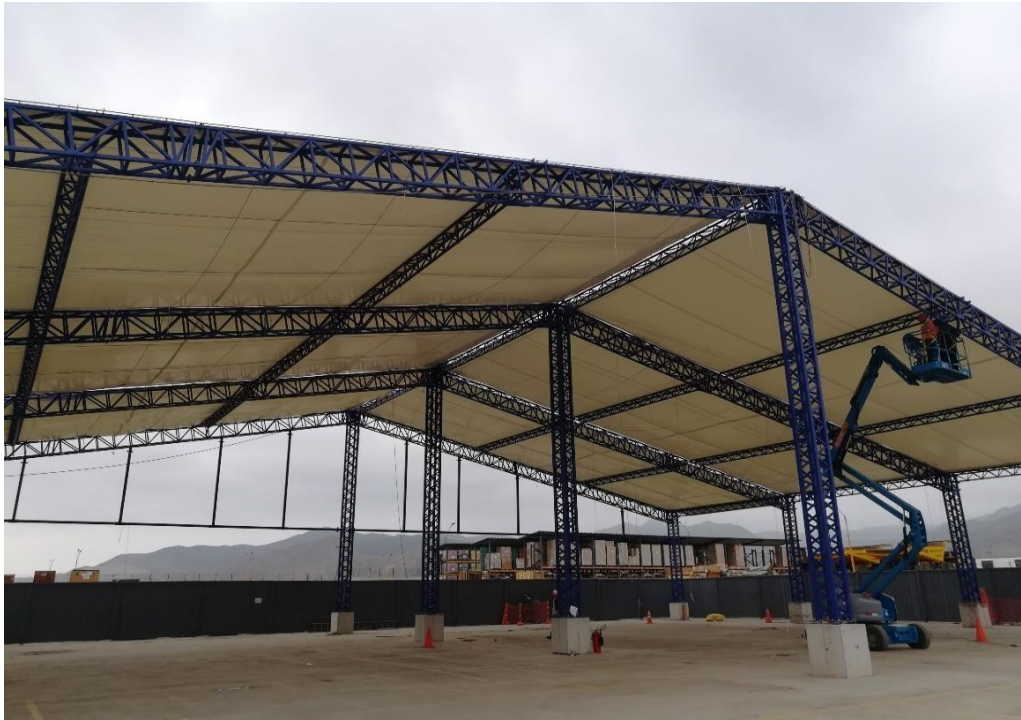
Imagen N°6 Instalación total de cobertura
