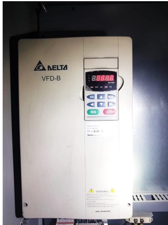
Figura 41. Variador de velocidad EVF-25D Fuente: Elaboración propia
