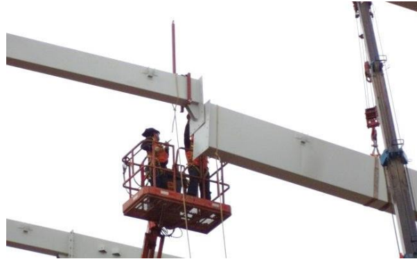
FIGURA N° 2.16 ENSAMBLE DE ESTRUCTURAS
