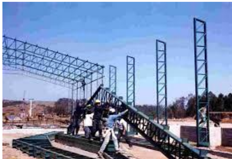
FIGURA N° 2.13 ARMADO DE ESTRUCTURAS EN SUELO
