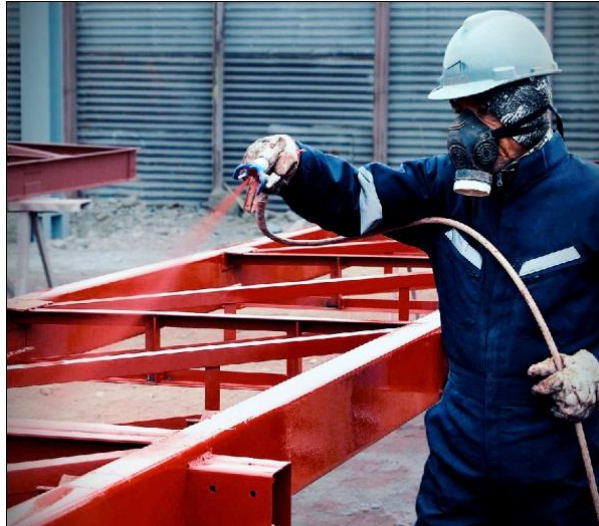
FIGURA N° 2.18 PINTADO DE ESTRUCTURAS
