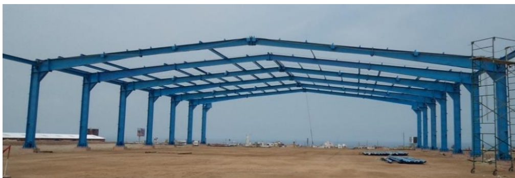
FIGURA N° 2.8 ESTRUCTURA TIPO PÓRTICO
