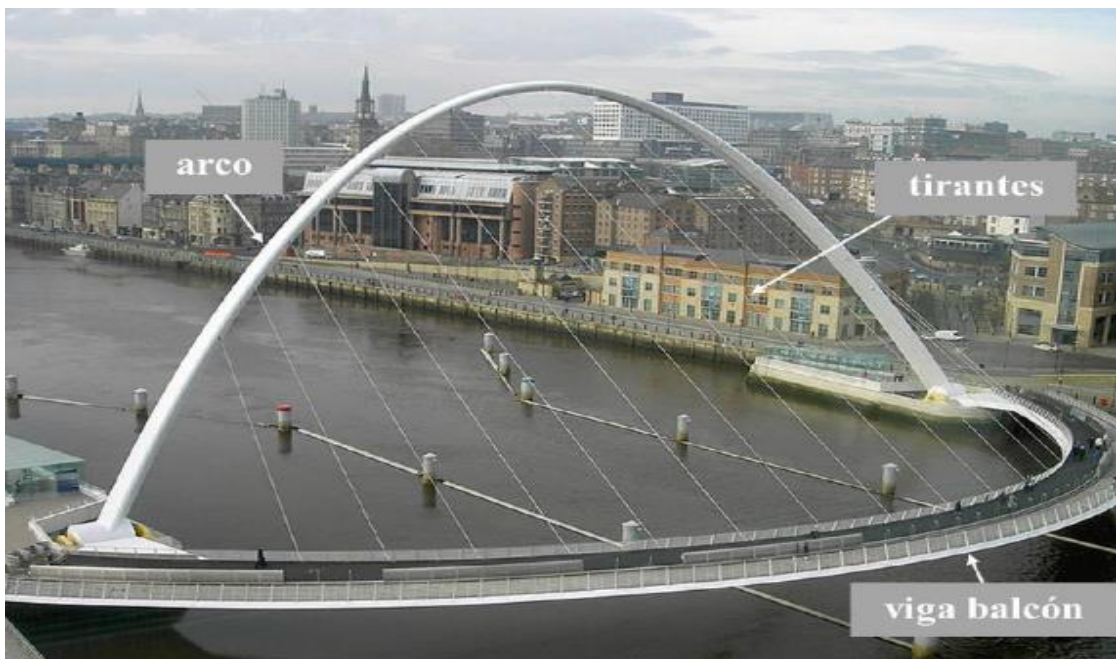
FIGURA N° 2.3 PUENTE DE VEHICULAR
