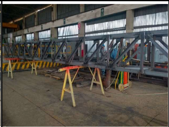
IMAGEN 8: Limpieza mecánica celosía 1_2 - Faja n° 2
