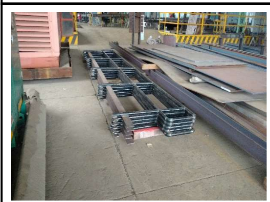
IMAGEN 9: Armado de Barandas Faja N° 2
