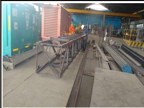
IMAGEN 7: Limpieza mecánica celosía 1_1 - Faja n° 2
