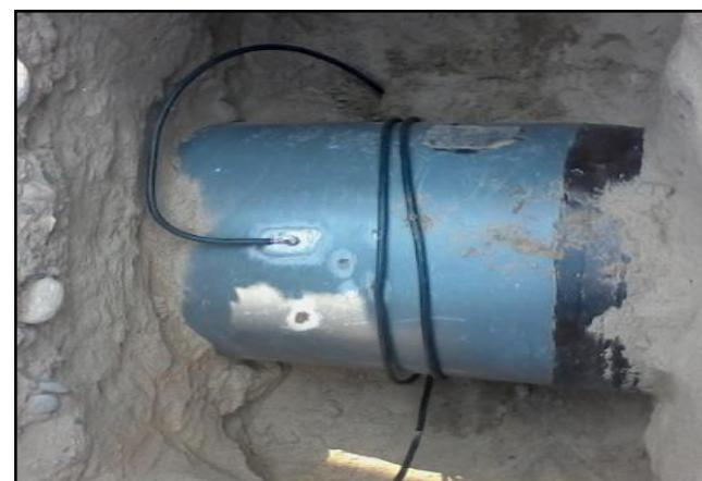
**Figura A7 SOLDADURA EXOTÉRMICA**
