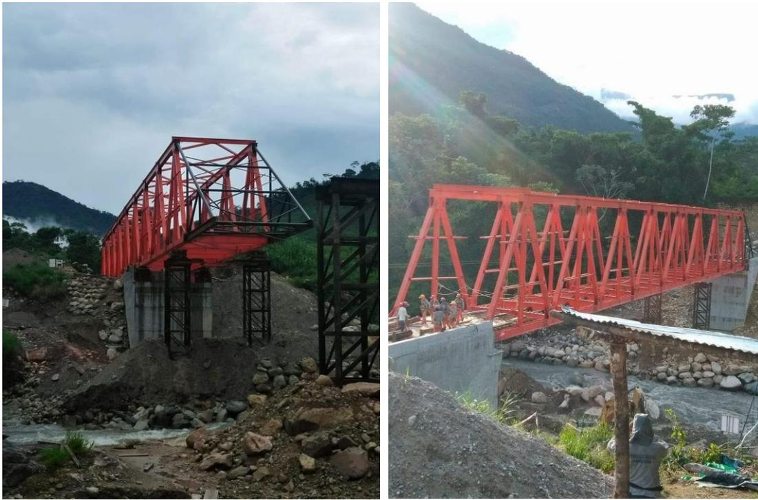
*Figura 47.*Montaje del Puente metálico vehicular de 169 Toneladas
