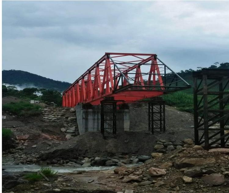
*Figura 11.*Lanzamiento del Puente Mariposa-Tocache.
