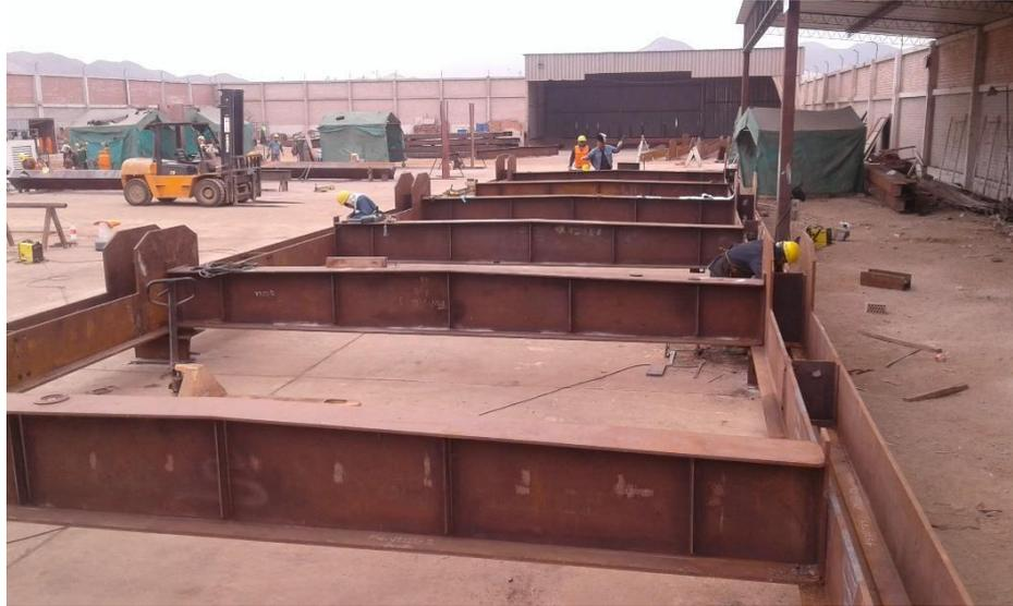
*Figura 10.*Fabricación de puente metálico reticulado.
