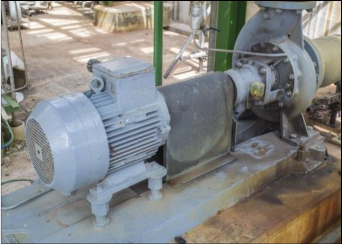
Figura N° 2.11 BOMBAS BOOSTER
