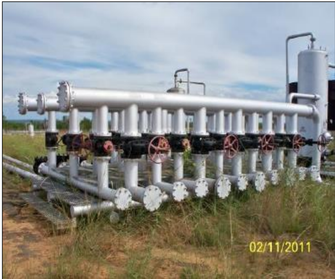
Figura N° 2.1 MANIFOLD DE PRODUCCIÓN
