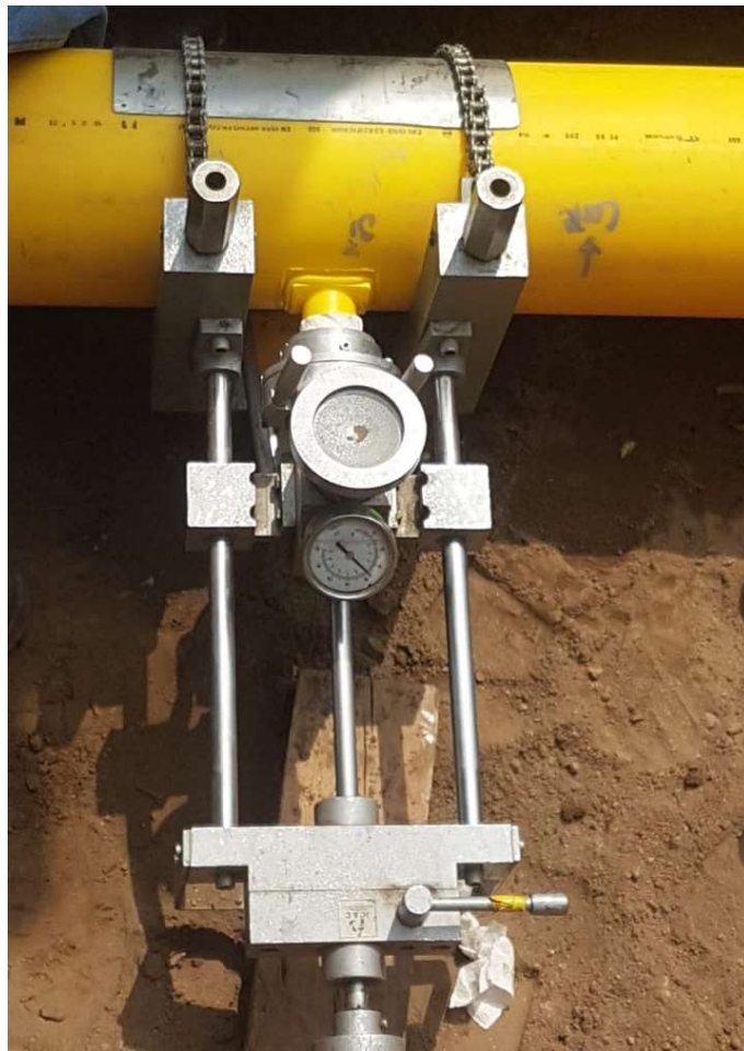
FIGURA N° 38 Instalación de portasilleta a tubería de 63 mm
