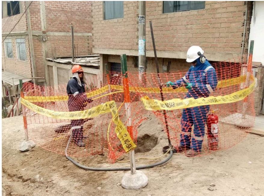
FIGURA N° 47 Barrido y medición de gas natural
