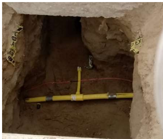
FIGURA N° 37 Uniones por termofusión a socket
