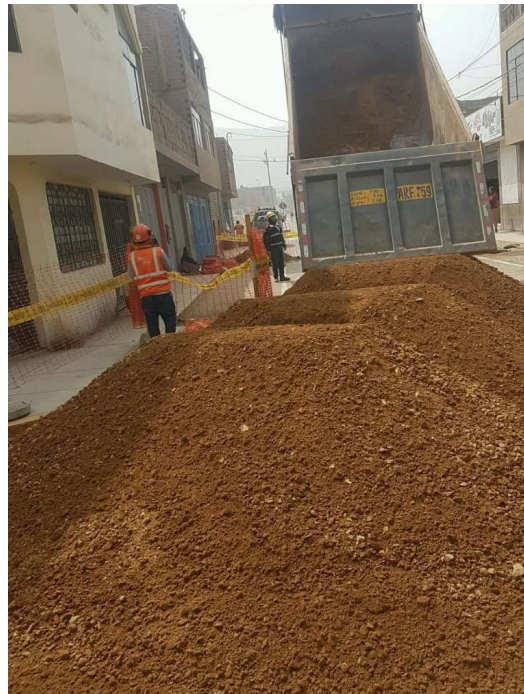
FIGURA N° 43 Afirmado proveniente de canteras
