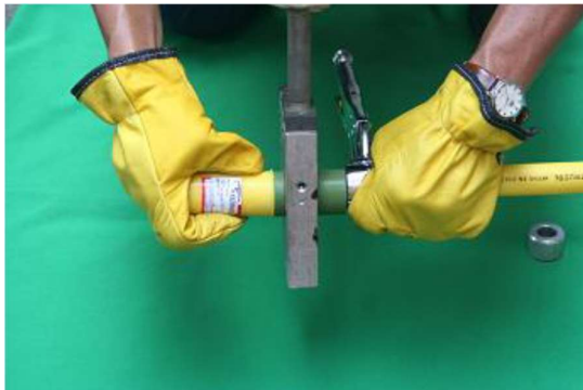
FIGURA N° 16 Unión por termofusión
