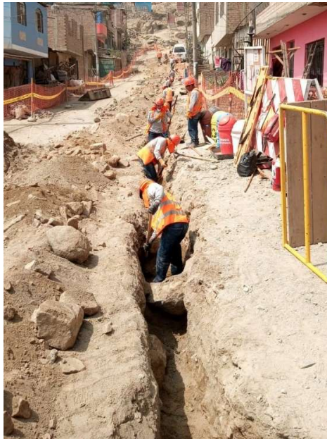
FIGURA N° 31 Excavación de zanja
