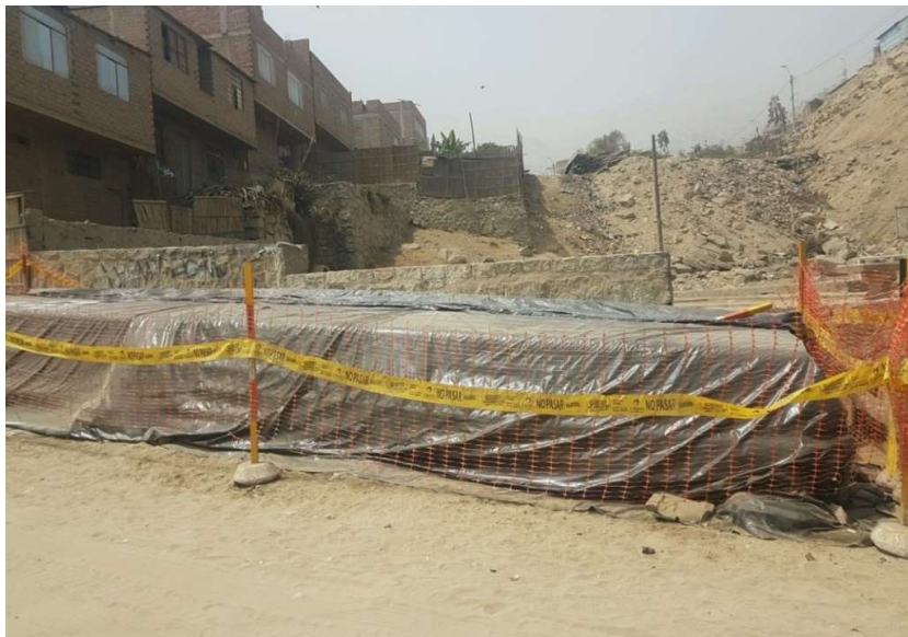
FIGURA N° 26 Almacenamiento de tuberías en obra
