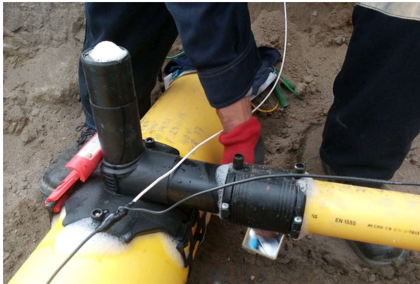
FIGURA N° 46 Verificación de fuga mediante agua jabonosa
