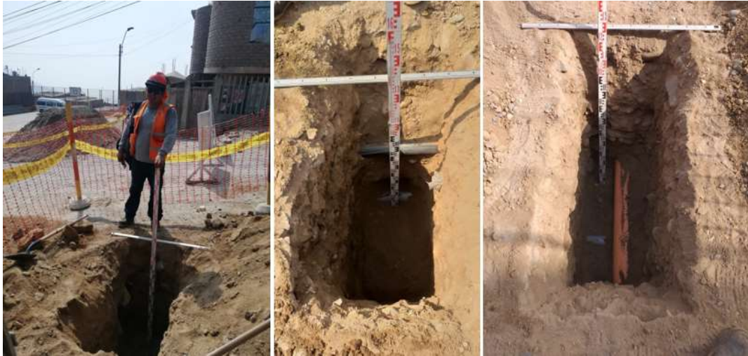
FIGURA N° 29 Calicatas con ubicación de interferencias
