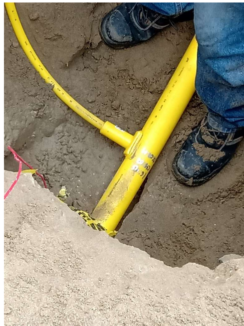
FIGURA N° 39 Uniones por termofusión a silleta
