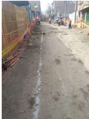
FIGURA N° 30 Trazado para excavación
