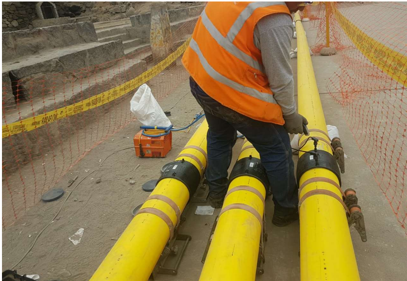
FIGURA N° 17 Unión por electrofundición
