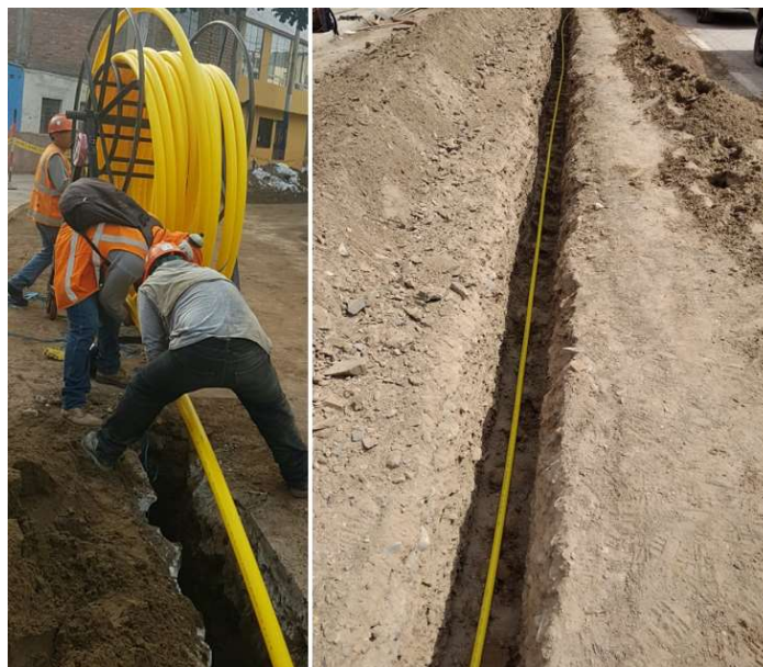
FIGURA N° 33 Tendido de tubería de Polietileno
