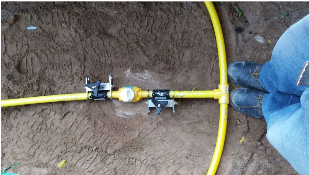
FIGURA N° 41 Uniones por termofusión a silleta
