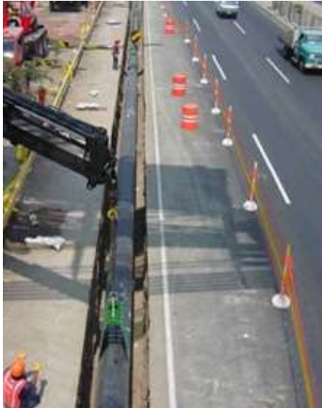
FIGURA N° 9 Obras de construcción de las redes principales de alta presión
