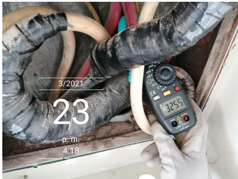
Ilustración 4. Tablero Eléctrico TD1 Avícola Avícola Conductor fase T.
