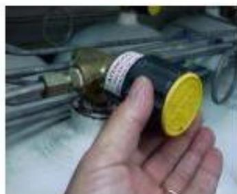
3. En el tablero eléctrico, en la bandeja de PLC, quitar el relé de disparo del tubo de CO<sub>2</sub>. Se lo identifica por el cable n° 247 naranja que está conectado a la base.
