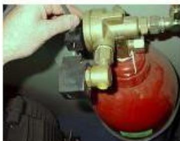
2. Cerrar las válvulas de los cilindros de almacenamiento de gas que estén abiertas.
