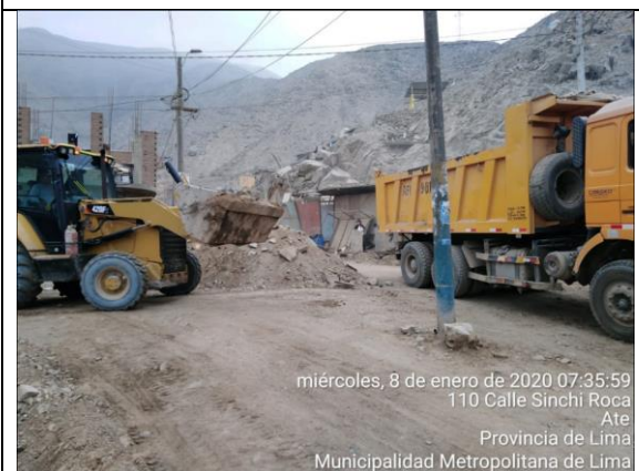
Segregación y Recolección de desmonte limpio
