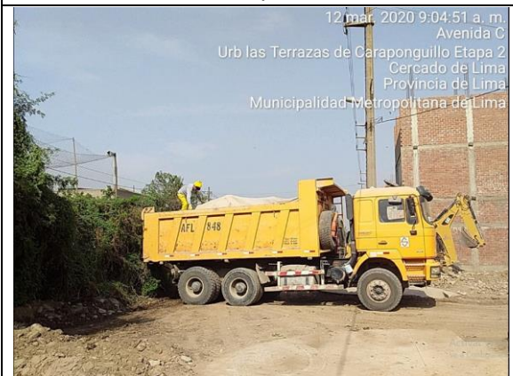
Transporte del desmonte limpio con el respectivo toldo
