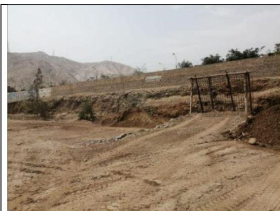
Almacenamiento para el Zarandeo del desmonte limpio reaprovechable
