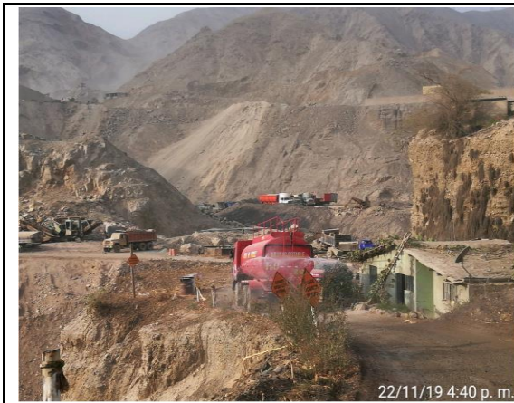
Riego durante la implementación para la habilitación del DME San Alejandro
