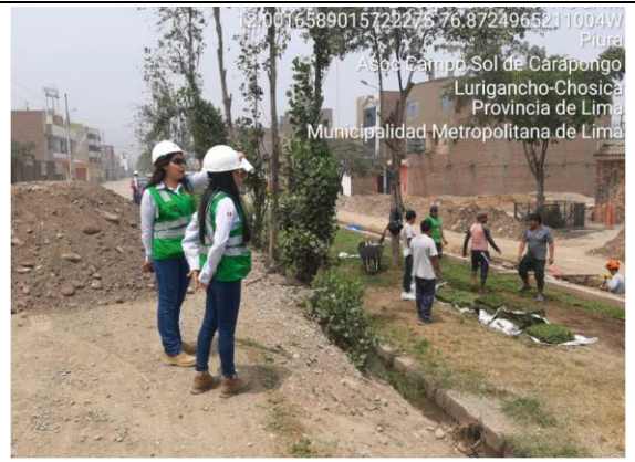
Verificando la correcta segregación del desmonte limpio en el frente de trabajo
