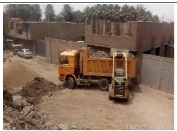
Segregación y Recolección de desmonte limpio
