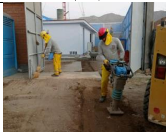
Valorización del desmonte limpio mediante el reaprovechamiento como material de relleno
