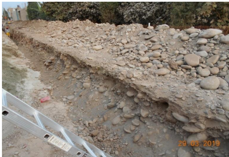
Figura 31. Material de excavaciones Lineales con presencia de botonería de buena calidad
