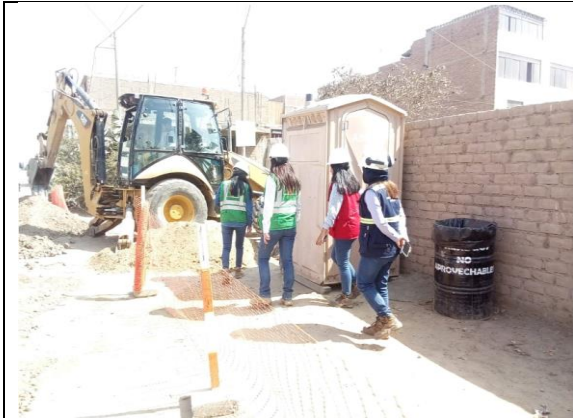
Control y seguimiento de la Supervisión de Obra y del Ministerio de Vivienda, Construcción y Saneamiento a las actividades generadoras del desmonte limpio
