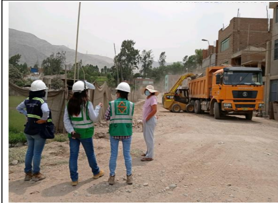
Control y seguimiento por parte de la Supervisión de Obra a la actividad de Recolección y Transporte del desmonte limpio
