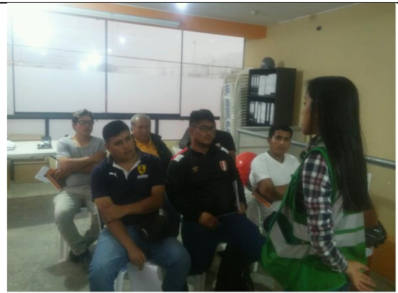
Brindando inducción al personal nuevo antes de su ingreso a la obra
