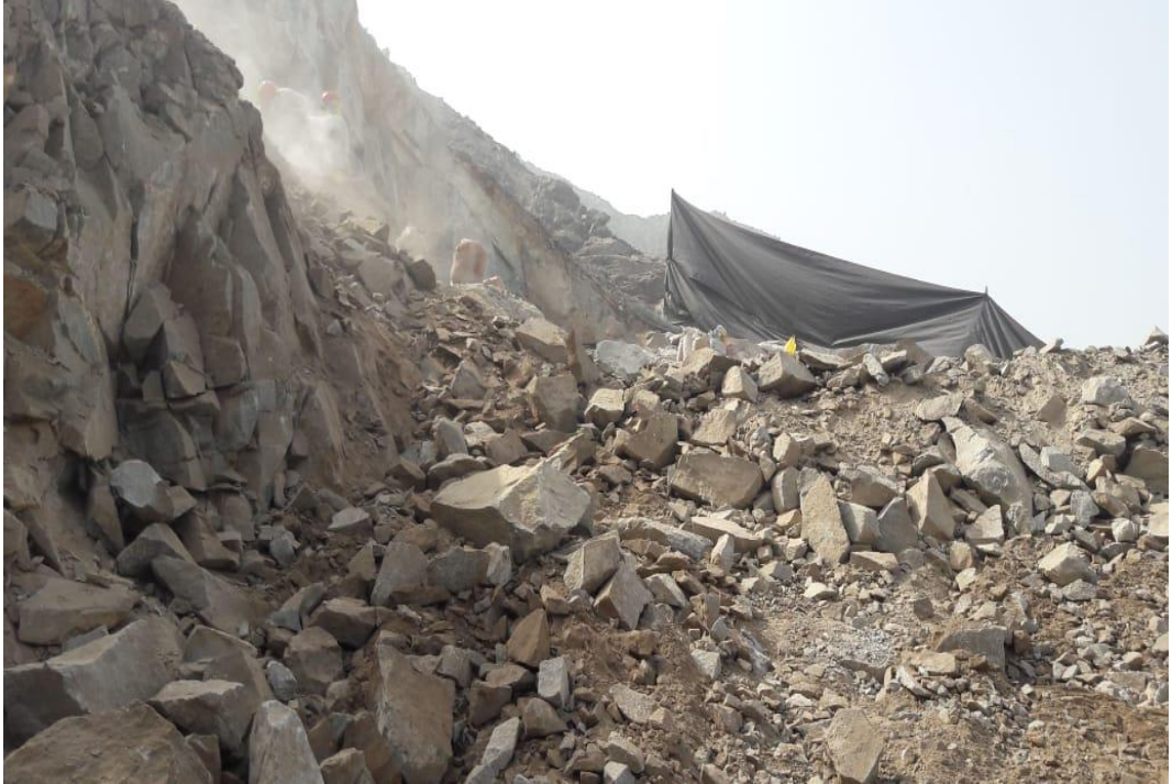
Figura 30. Material rocoso proveniente de la Excavación de Reservorios
