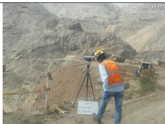
Monitoreo de ruido ambiental en la etapa de Acondicionamiento del DME San Alejandro 2012
