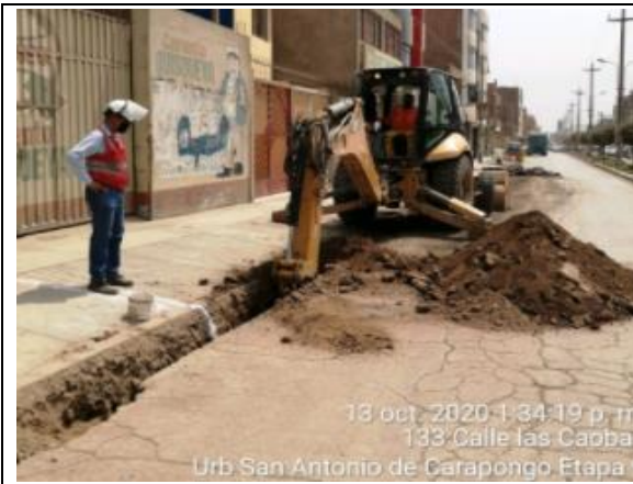
Generación de desmonte limpio por movimiento de tierras en obras lineales
