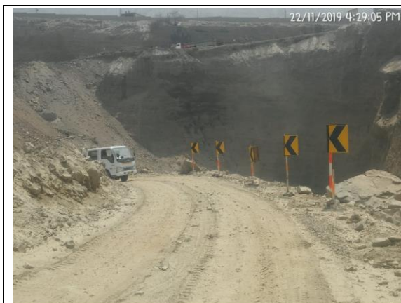
Implementación de señalización de tránsito durante la etapa de Acondicionamiento.
