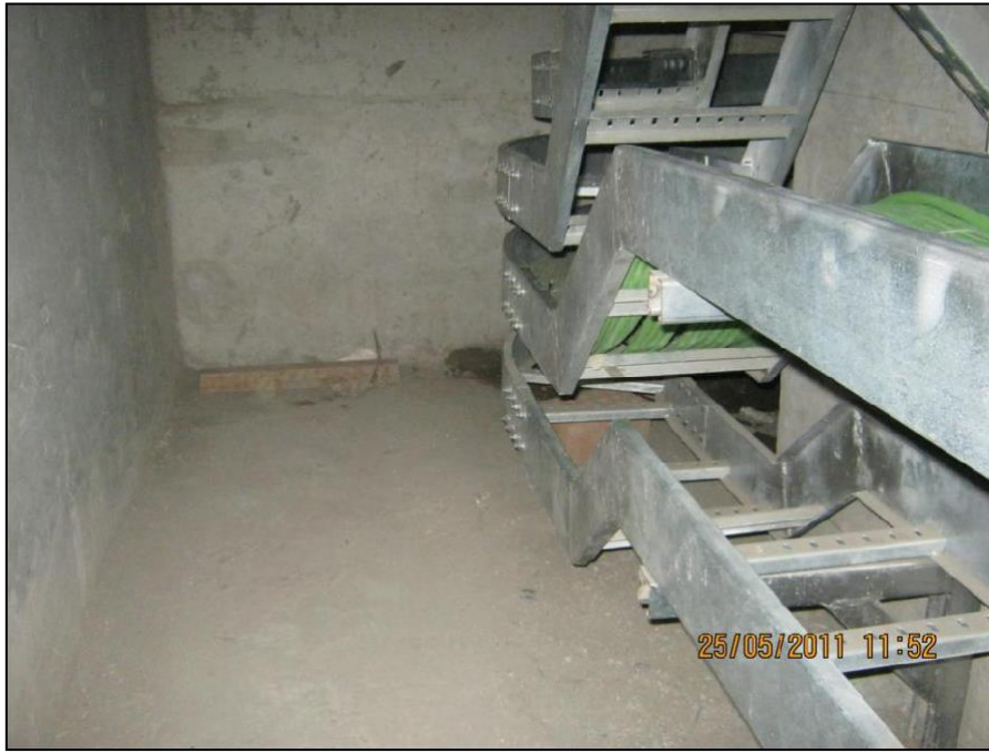
Fig. 4.2: Cableado de F, C bajo Canaletas área motores de deshornamiento
