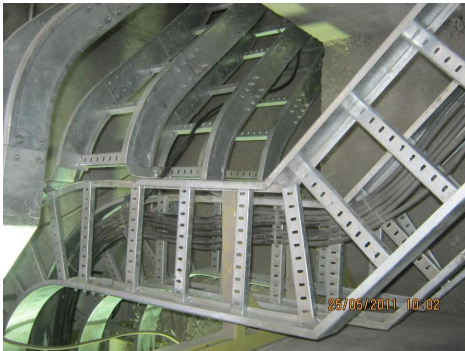
Fig. 4.2: Cableado de F, C bajo Canaletas área motores de deshornamiento
