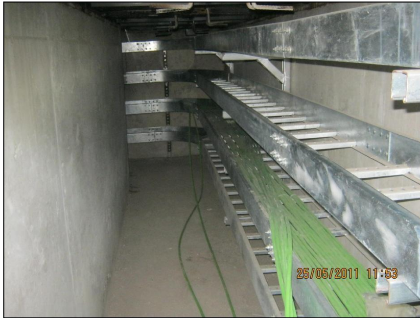
Fig. 1.4: Soportes, bandejas y tuberías conduit área Sótano del horno
