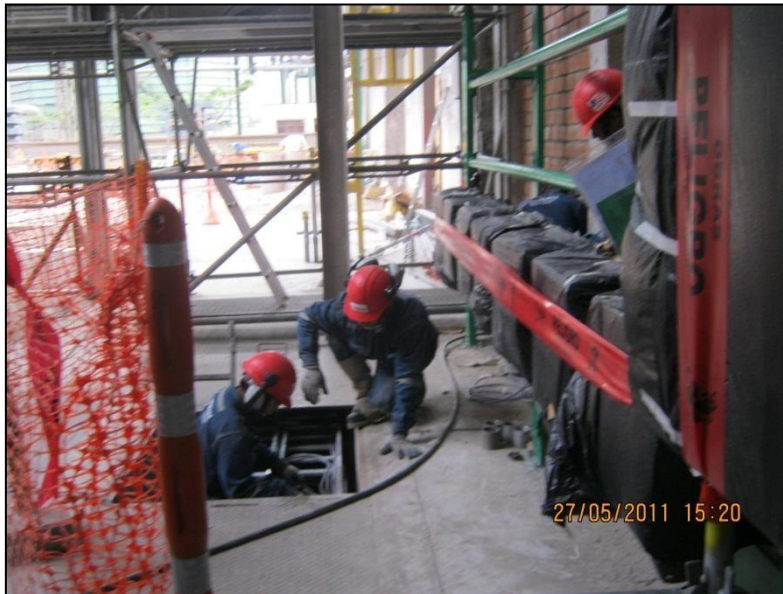
Fig. 3.1: Montaje Paneles remotos
