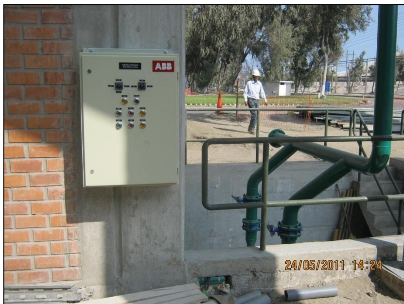
Fig. 2.2: Tablero de fuerza y control de bombas
