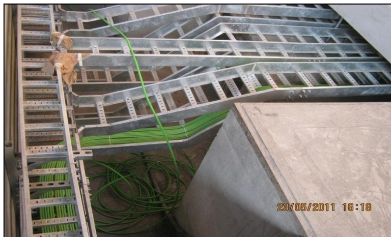
Fig. 1.2: Soportes, bandejas y tuberías conduit en techo del horno
