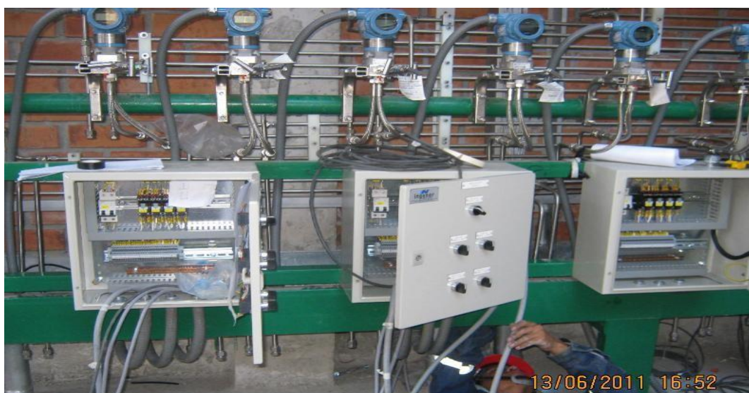
FIGURA 18: TRABAJOS DE MONTAJE
