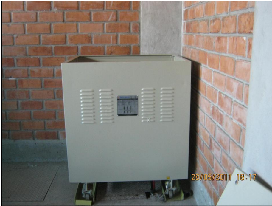
Fig.2.5: Montaje Transformador BT
