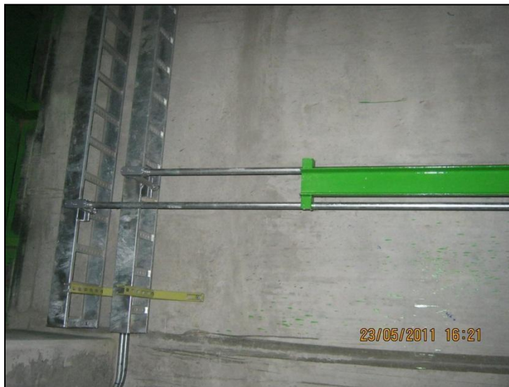
Fig. 1.4: Soportes, bandejas y tuberías conduit área Sótano del horno
