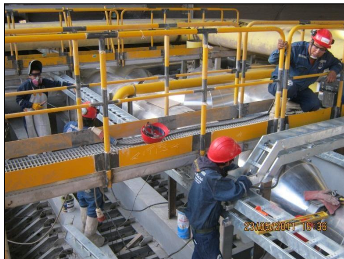
Fig. 1.2: Soportes, bandejas y tuberías conduit en techo del horno
