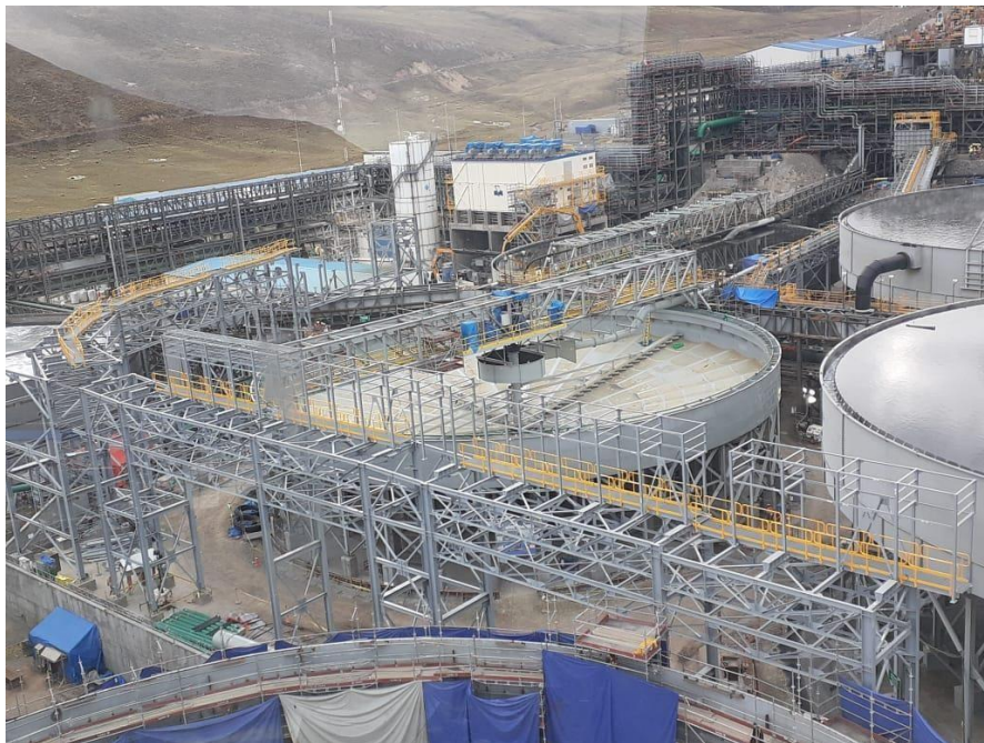
Figura N°3.36 MONTAJE DE PIPE RACK Y ESPESADOR TK-008
