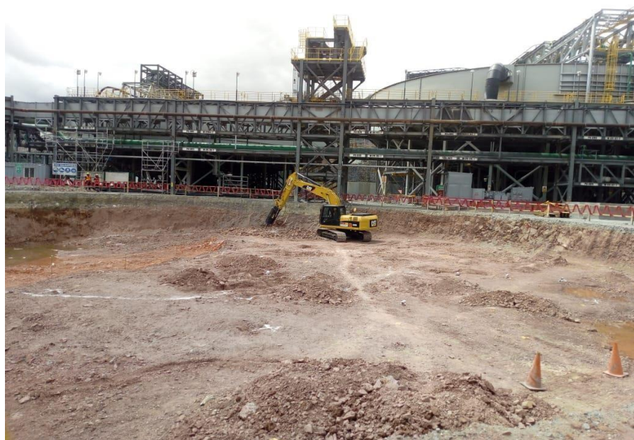
Figura N°3.6 MOVIMIENTO DE TIERRAS DEL ESPESADOR TK-0008
