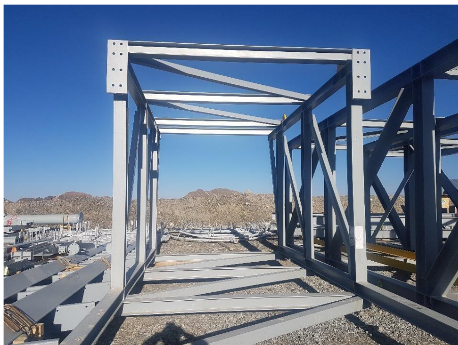
Figura N°3.23 ESTRUCTURAS DE UN PUENTE DE ESPESADOR FUERA DEL ALCANCE DE HAUG
