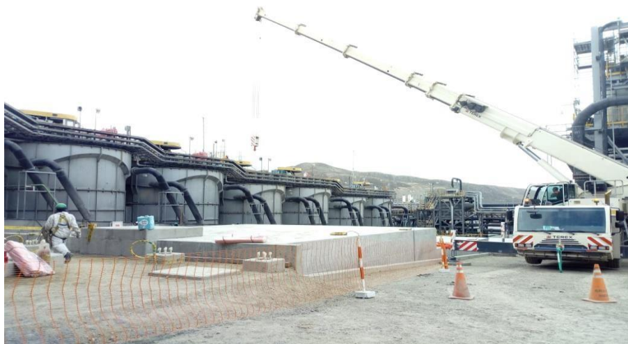
Figura N°3.4 CIMENTACIONES DE LAS CELDAS Y GRÚA TELESCOPICA
