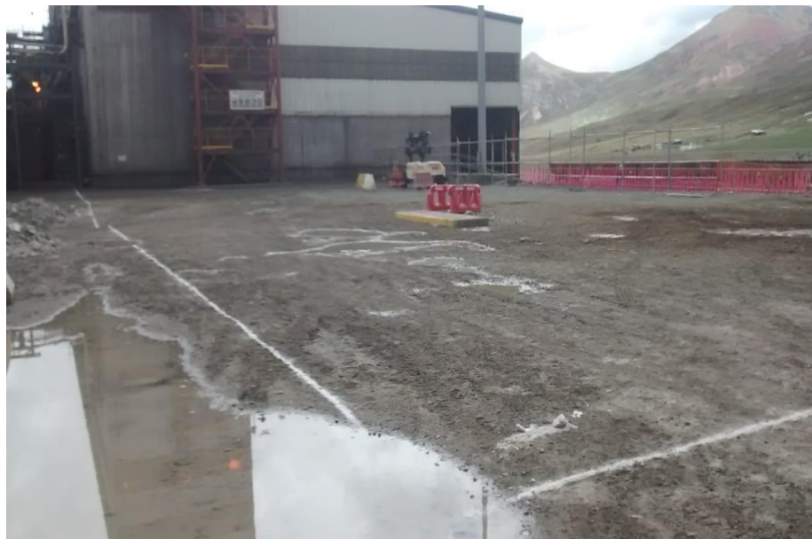
Figura N°3.10 DELIMITACIÓN DE EDIFICIO DE FILTROS
