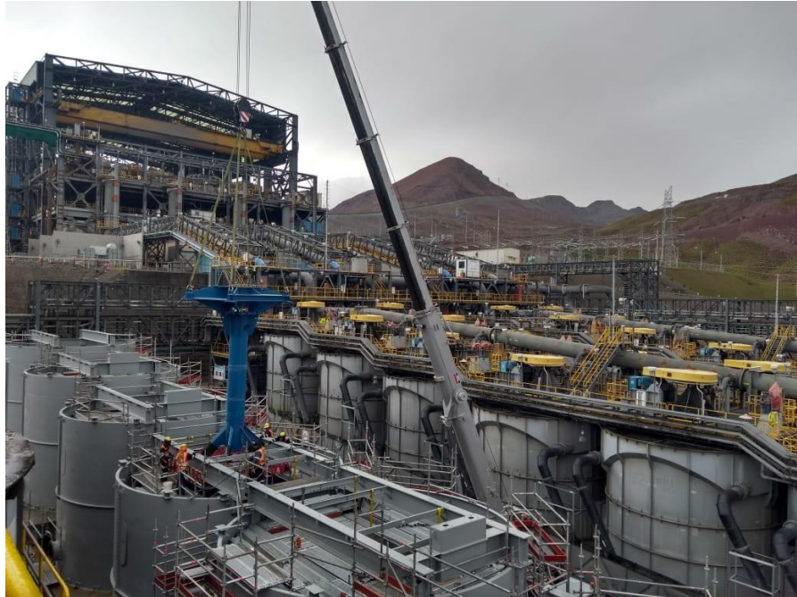
Figura N°3.35 MONTAJE DE LAS CELDAS DE FLOTACIÓN
