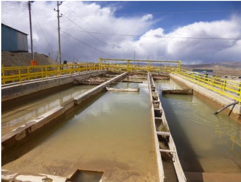
**Figura 24.** Vista general de las cámaras de sedimentación en superficie.
