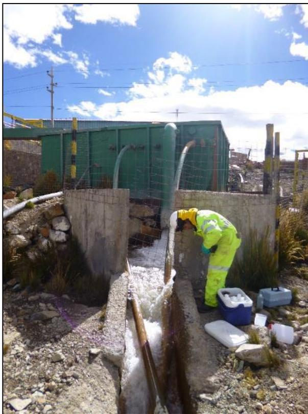
**Figura 7.** Ingreso de agua de mina a sistema de tratamiento físico químico en superficie.
