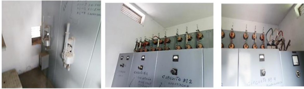
Imagen 3 - Celda de llegada y salida con obsolescencia técnica.
