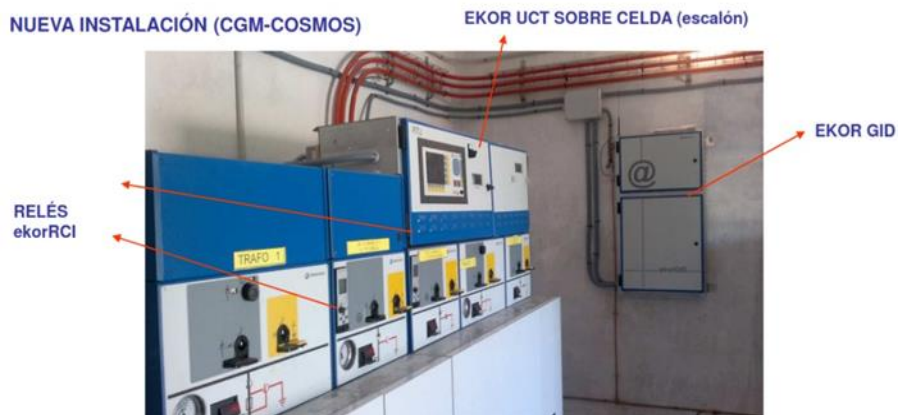
Figura 42 - Elementos principales CT Automatizado.
