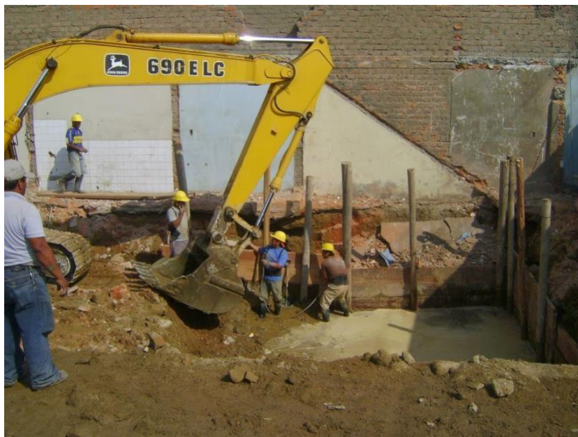
FIGURA N° 4.10 EXCAVACION DE CAJON PORTA TANQUE LÍQUIDO
