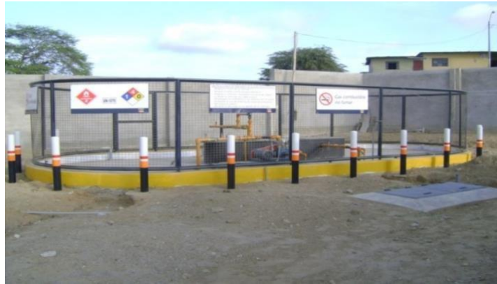
FIGURA N° 3.1 CERCO PERIMETRICO DE TANQUE GLP
