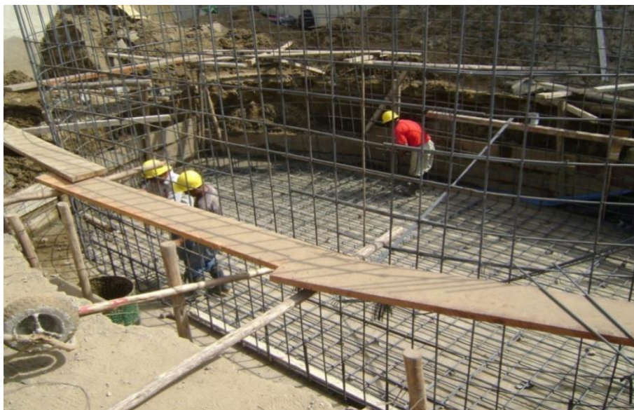
FIGURA N°3.4 MALLA DE CAJON PORTA TANQUE DE GLP
