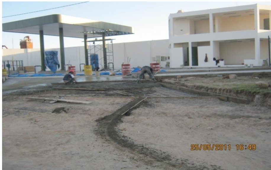
FIGURA N° 3.3 ESTACION DE SERVICIO LLAMAGAS -AREQUIPA
