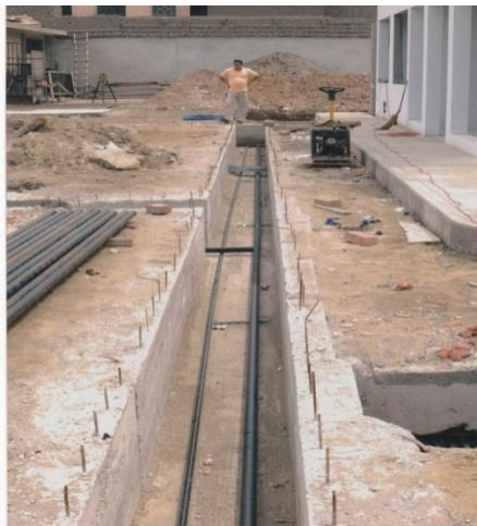
FIGURA N° 4.9 CANAL DE GLP DE CONCRETO ARMADO
