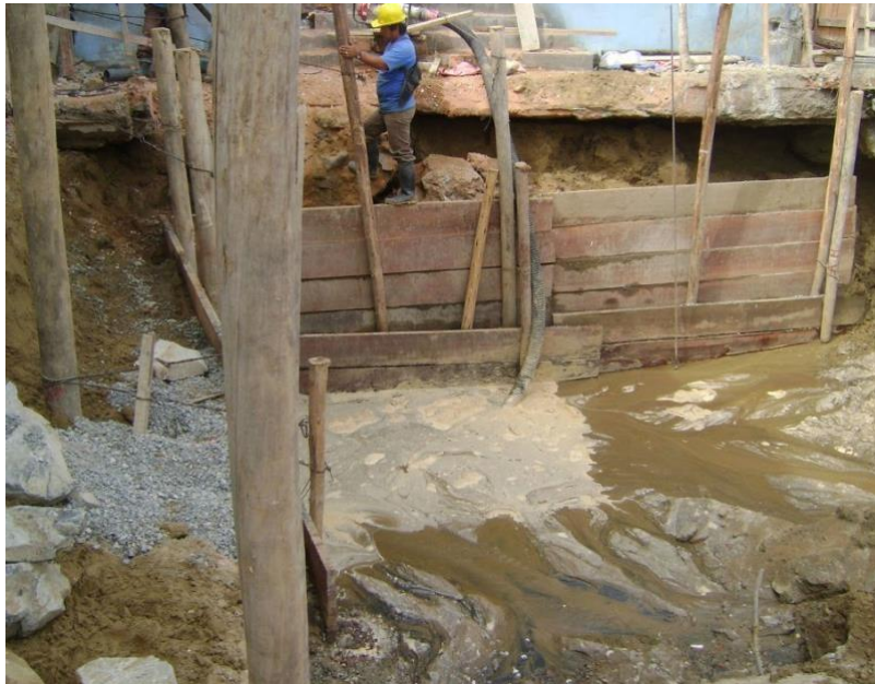
FIGURA N° 4.11 ELIMINACION DE AGUA Y ENTUBADO DE FOSA
