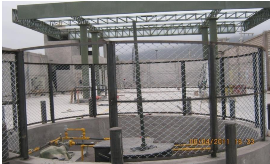
FIGURA N° 3.5 FABRICACION DE TECHO METALICO Y ESTRUCTURAS METALICAS CERCO PERIMETRICO GLP
