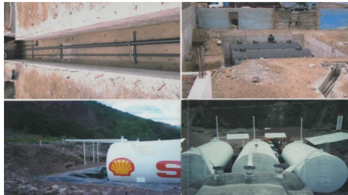
FIGURA N° 3.2 INSTALACION TANQUES Y TUBERIAS
