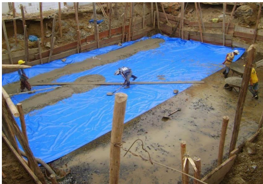
FIGURA 4.12 SOLADO DE CAJON PORTA TANQUE LIQUIDOS
