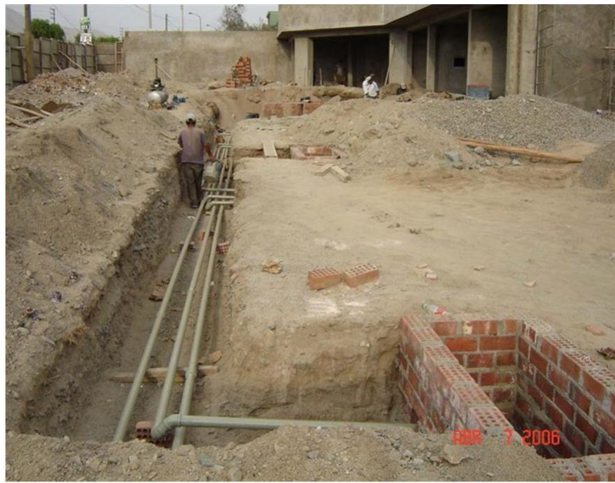
FIGURA N° 4.17 TENDIDO DE TUBERIAS DE SUCCION 2"
