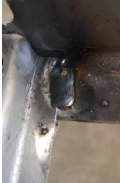
Imagen 29 Zona de empalme soldada
