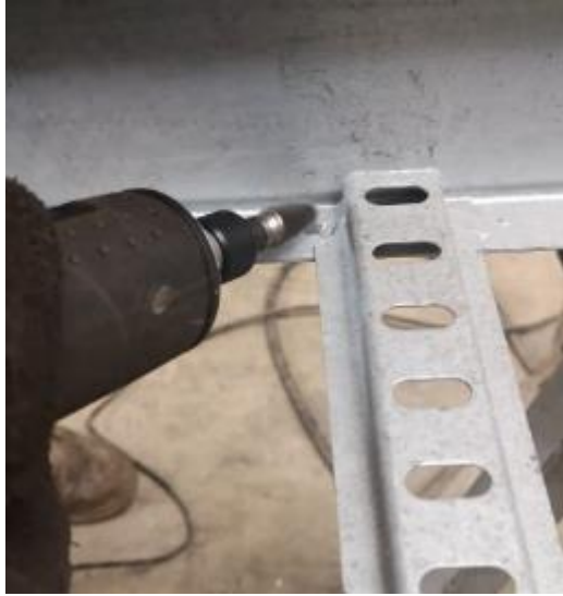
Imagen 27 Proceso de limpieza de cordón de soldadura
