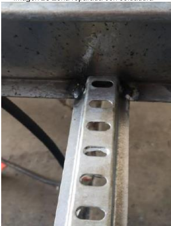
Imagen 25 Zona reparada con soldadura
