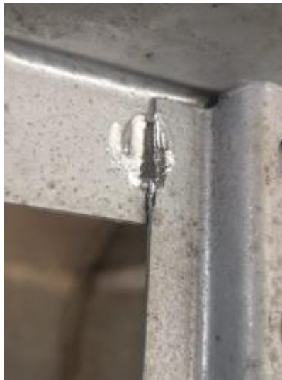
Imagen 31 Cordón retirado manualmente
