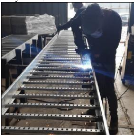
Imagen 24 Reparación con soldadura GMAW
