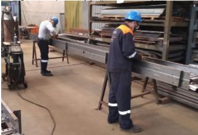
Imagen 71 Inspección y limpieza de bandejas soldadas
