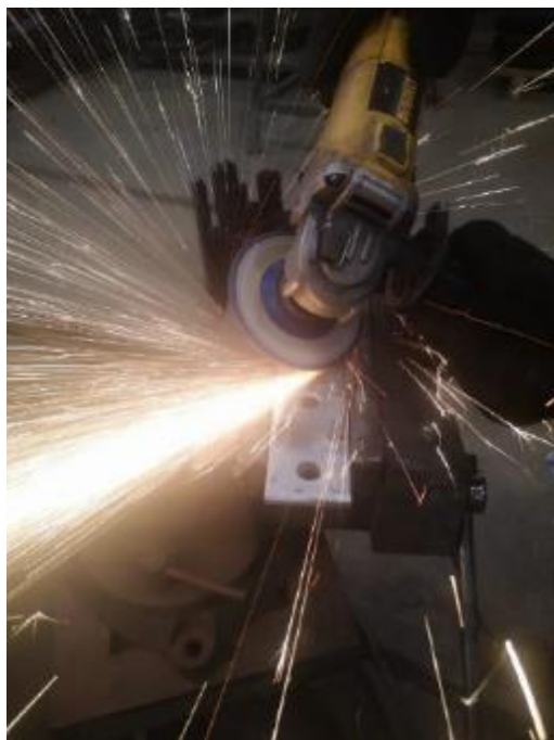
Imagen 35 Retiro de remanentes de soldadura
