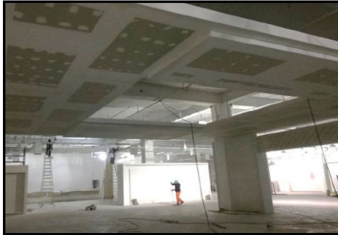
Figura 1.12 Instalación de drywall en tienda OECHSLE
