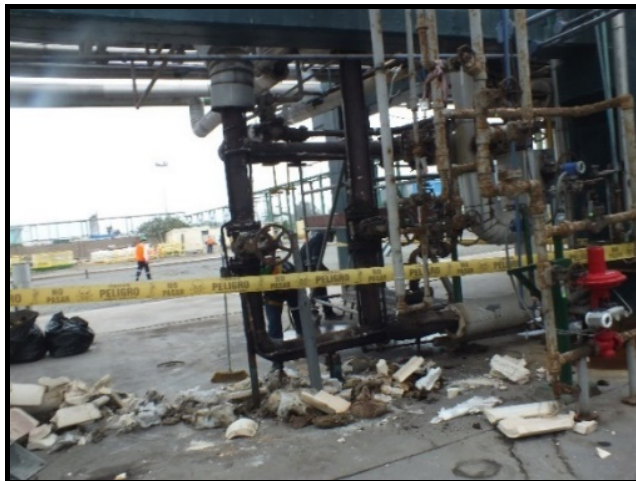
Figura 3.7 Retiro de aislamiento térmico en mal estado
