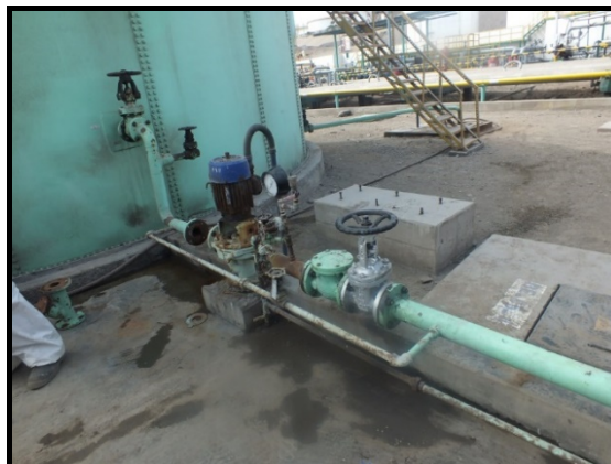
Figura 1.3 Válvula de compuerta reemplazada
