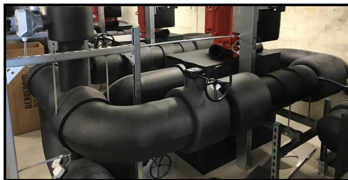
Figura 2.23 Aislamiento en sistemas de enfriamiento
