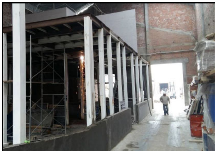
Figura 1.9 Proceso constructivo planta agrícola Montana
