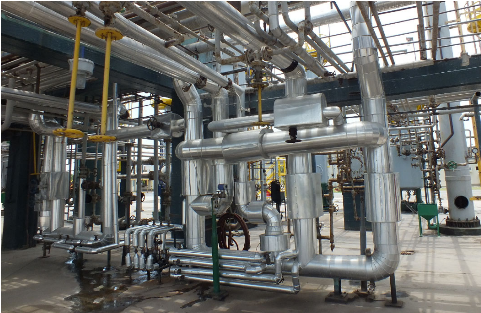
Rack de tuberías: Después de instalar aislamiento a las líneas de proceso
