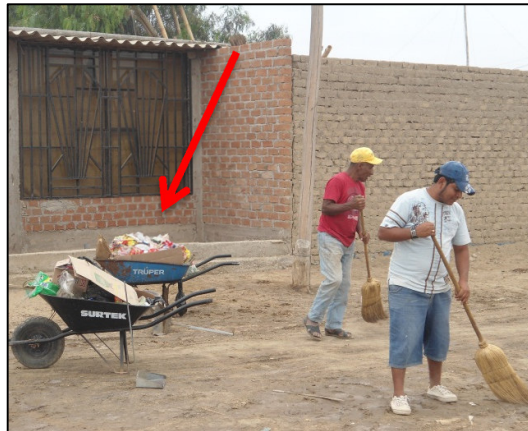
Foto: Personal de barrido con inadecuadas herramientas, equipos de barrido y sin EPP.
