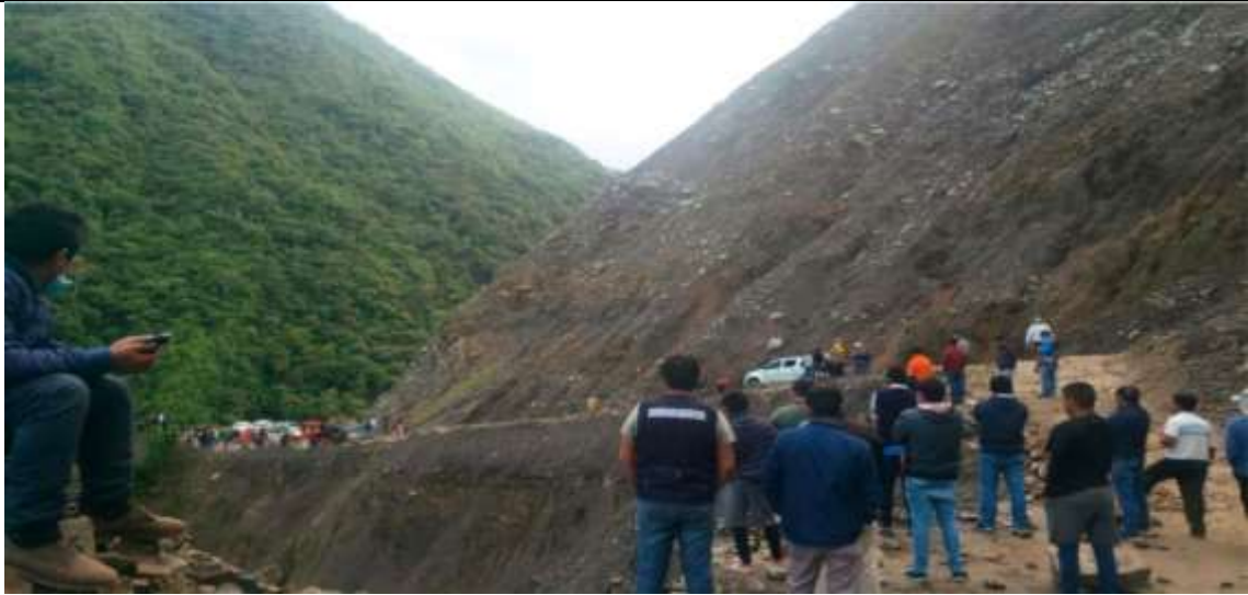
Imagen 1: Vía Ccano-Sivia: zona peligrosa con riesgo de deslizamiento de tierra y riesgo de accidente de tránsito
