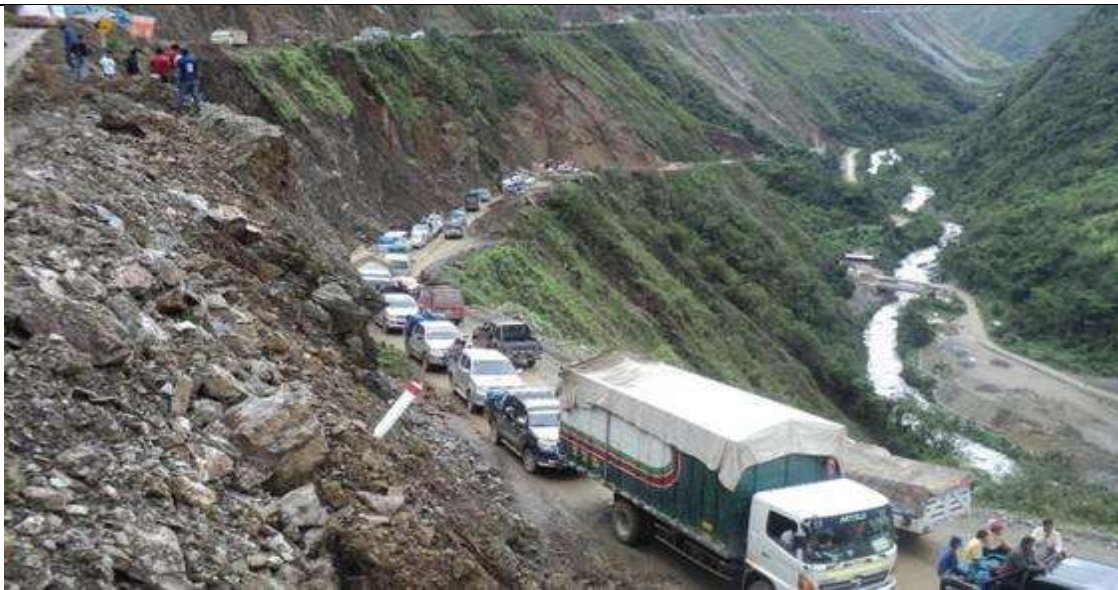
Imagen 2: vía Ccano-Rosario, derrumbes constantes con riesgo de entierro de unidades móviles
