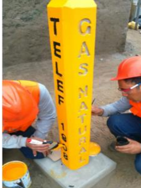
Figura 3. 106 INSTALACIÓN DE POSTES
