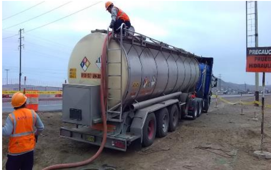
Figura 3. 81 LLENADO DE LA LÍNEA CON AGUA CERTIFICADA
