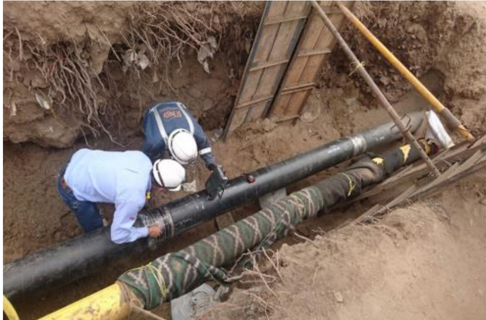
Figura 3. 66 INSPECCIÓN POR ULTRASONIDO
