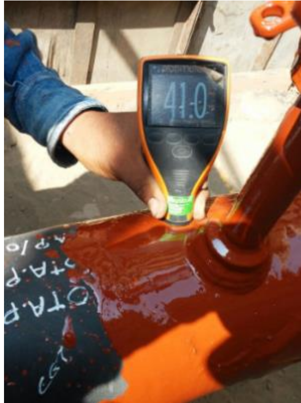
Figura 3. 71 VERIFICACIÓN DE ESPESOR DE RECUBRIMIENTO.
