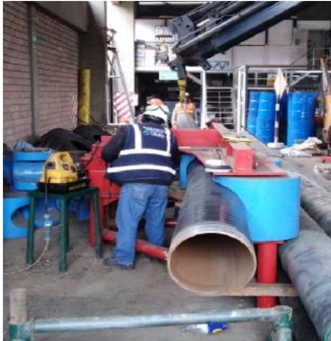
Figura 3. 59 CURVADO DE TUBERÍA EN TALLER.
