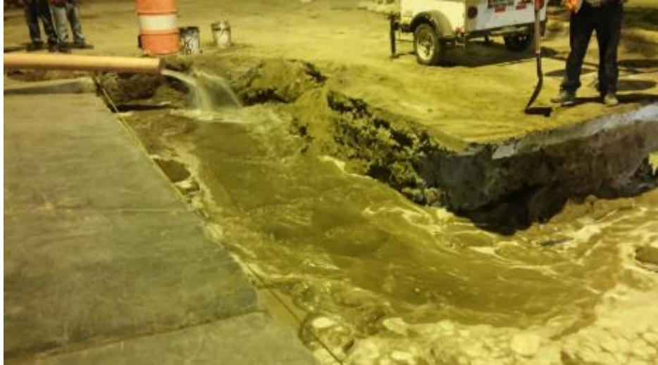
Figura 3. 96 TAPADO Y COMPACTACIÓN HIDRÁULICA.
