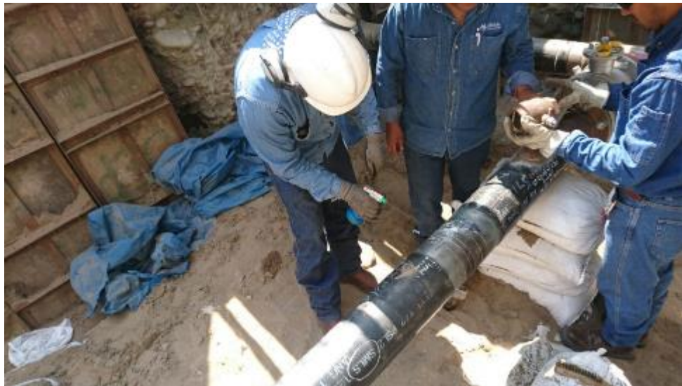
Figura 3. 121 VERIFICACIÓN DE FUGAS EN GASIFICACIÓN
