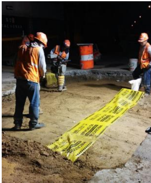
Figura 3. 97 COMPACTACIÓN Y COLOCACIÓN DE CINTA.
