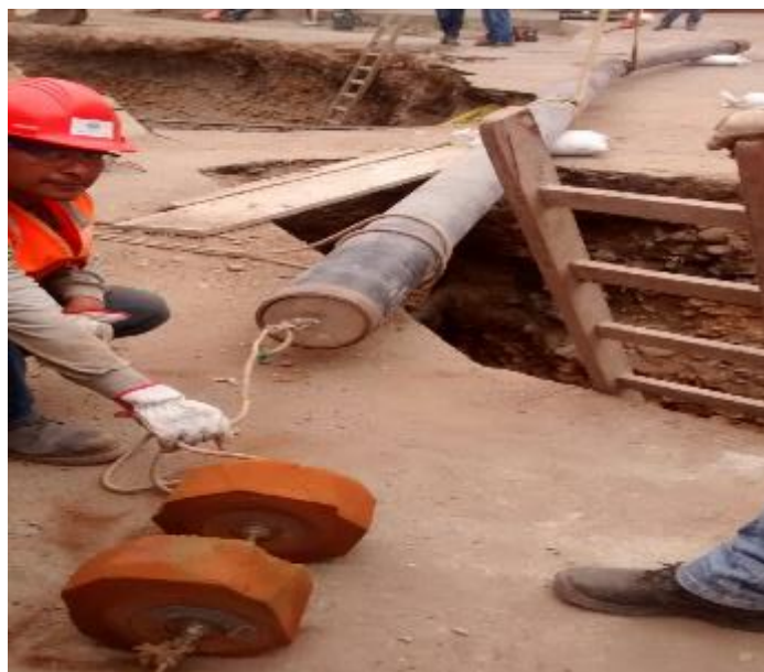
Figura 3. 60 PASAJE DE DISCO CALIBRADOR.
