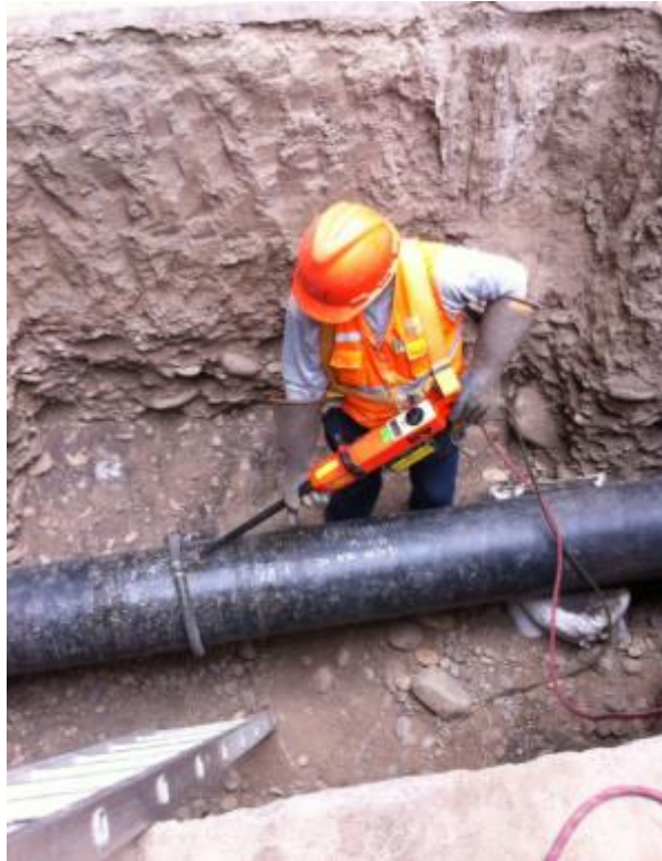
Figura 3. 72 VERIFICACIÓN DEL REVESTIMIENTO
