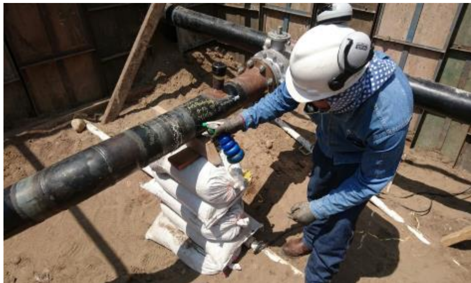
Figura 3. 122 VERIFICACIÓN DE FUGAS EN GASIFICACIÓN
