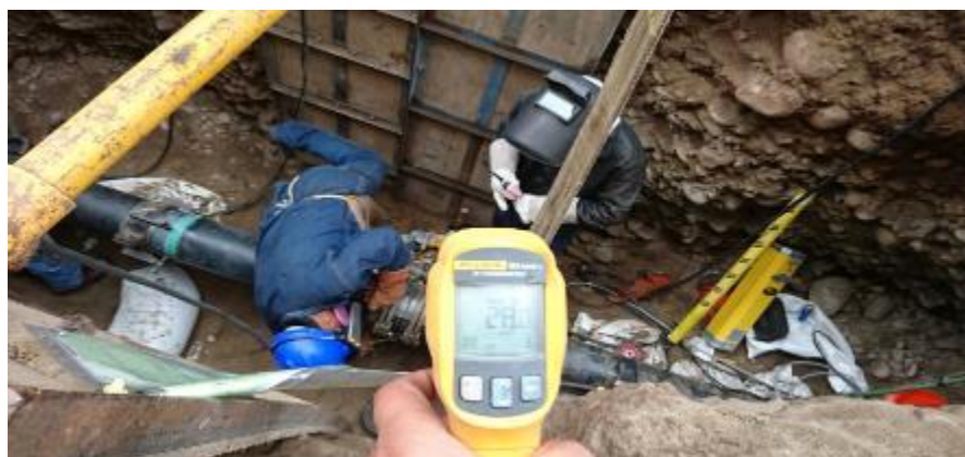
Figura 3. 64 VERIFICACIÓN DE PRECALENTAMIENTO
