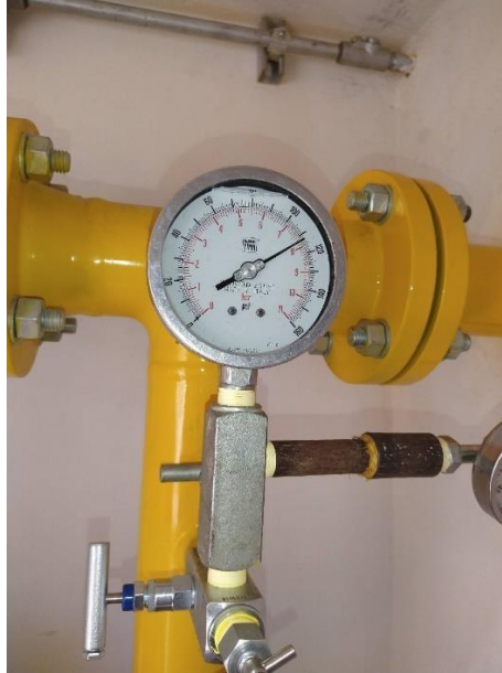
Figura 3.38: Prueba de hermeticidad en presencia de OSINERGMIN - 3.
