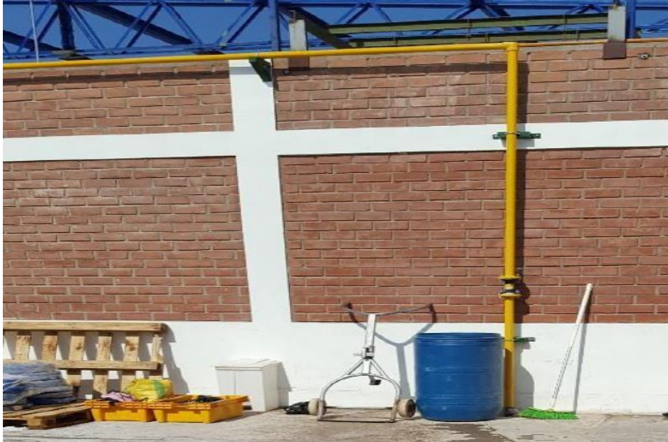
Figura 2.16: Montaje de tubería adosadas en paredes.
