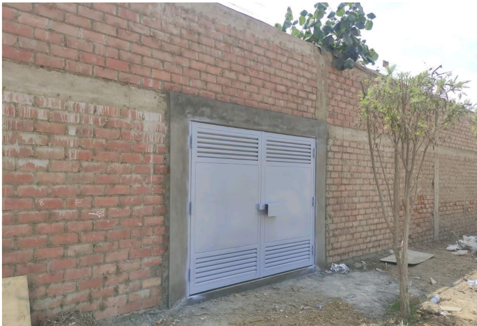
Figura 3.9: Instalación de puerta batiente - Estación de Filtración Primaria EFMP.
