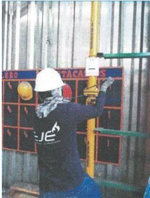
Figura 3.32: Ajuste con torquimetro de todas las uniones entre bridas
