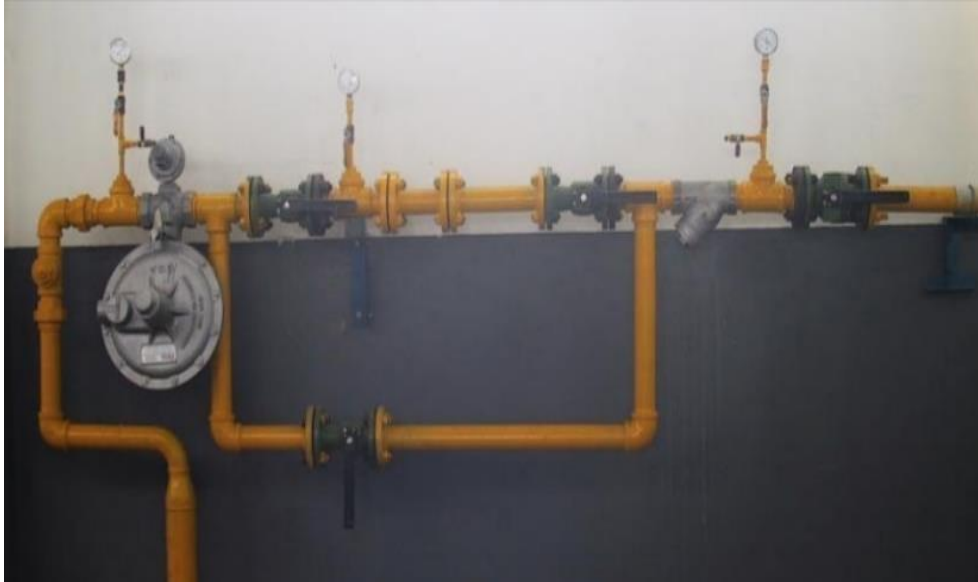
Figura 2.19: ERS ( Esquema de Estación de Regulación Secundaria ).
