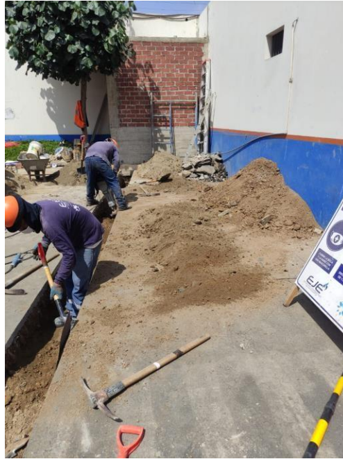
Figura 3.12: Excavación de zanja para la instalación de tubería HDPE - 1.
