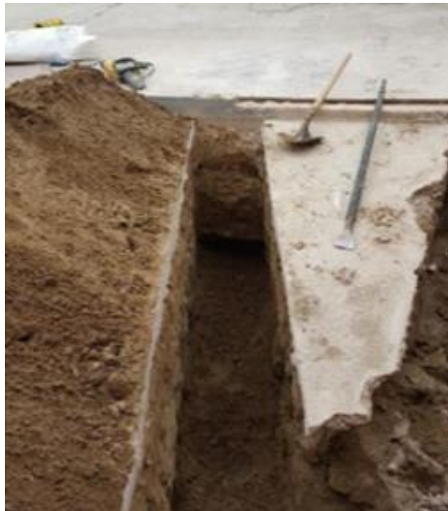
Figura 2.12: Excavación para el tendido de tuberías de acero.
