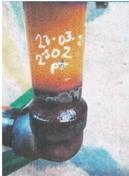
Figura 3.30: Prueba de tintes penetrantes a las uniones soldadas - 1.
