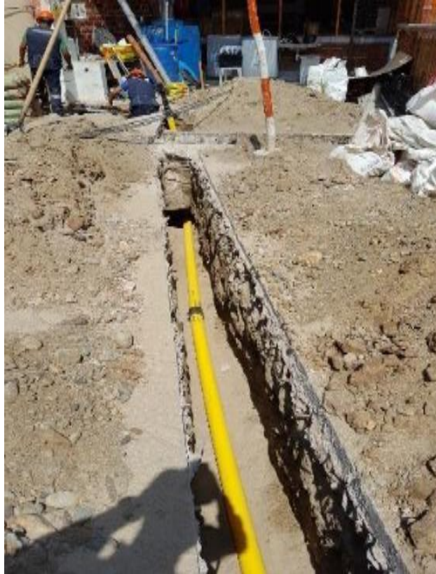
Figura 2.18: Montaje de tubería enterradas.
