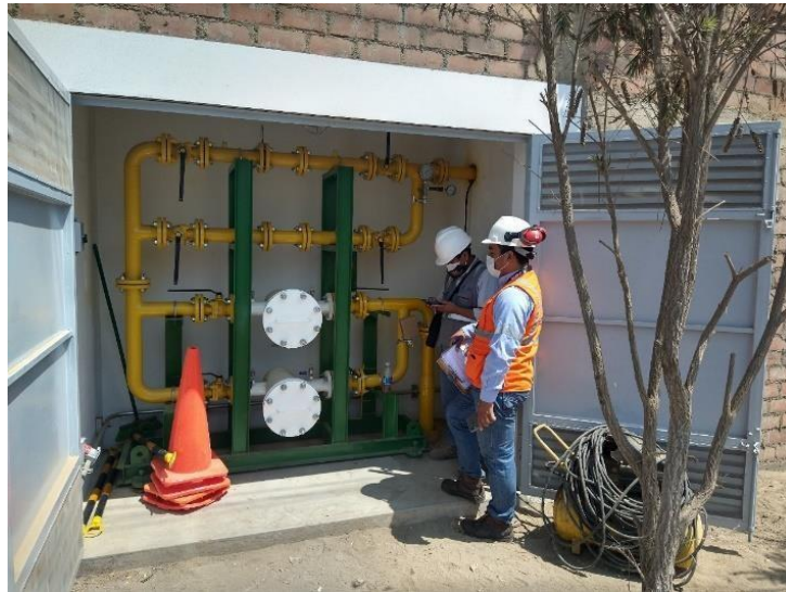
Figura 3.36: Prueba de hermeticidad en presencia de OSINERGMIN - 1.
