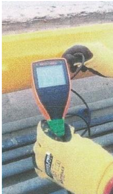
Figura 3.29: Medición de los mills después del pintado de las tuberías.
