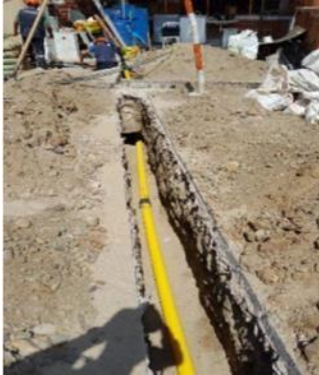
Figura 2.13: Tendido de tuberías de acero.
