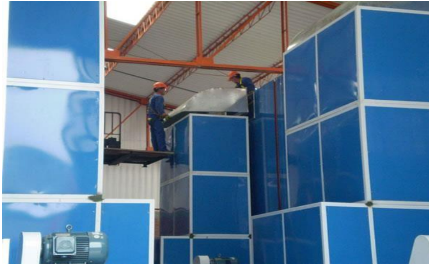
Figura 2.20: Exterior de la cabina de pintura Modabus.
