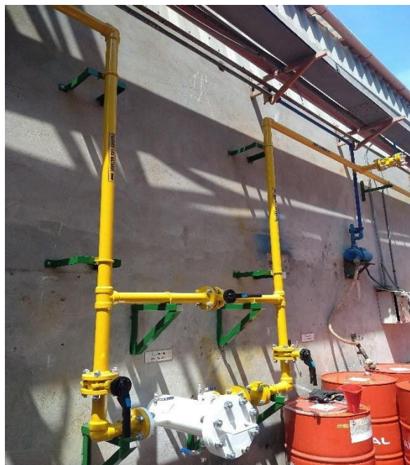
Figura 3.23: Red Interna de GN Estación de medición secundario Modabus.
