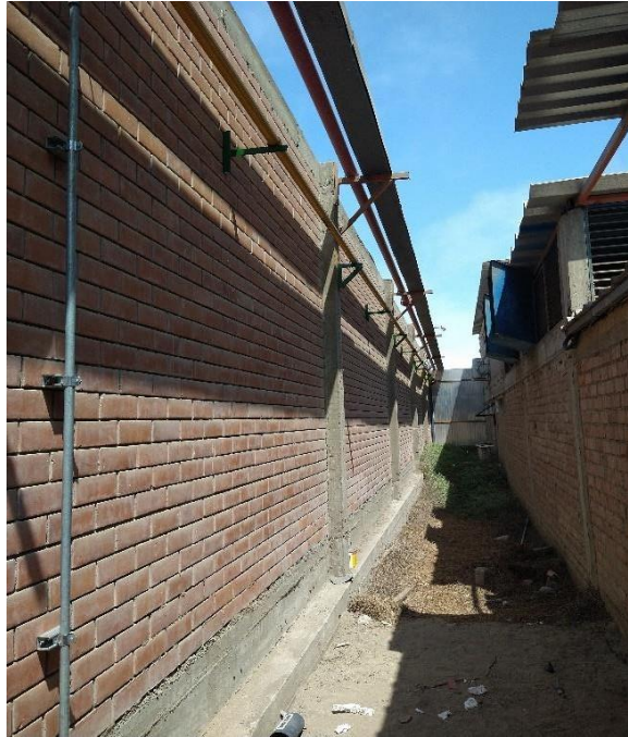
Figura 3.22: Red Interna de GN recorrido por el perímetro predial.
