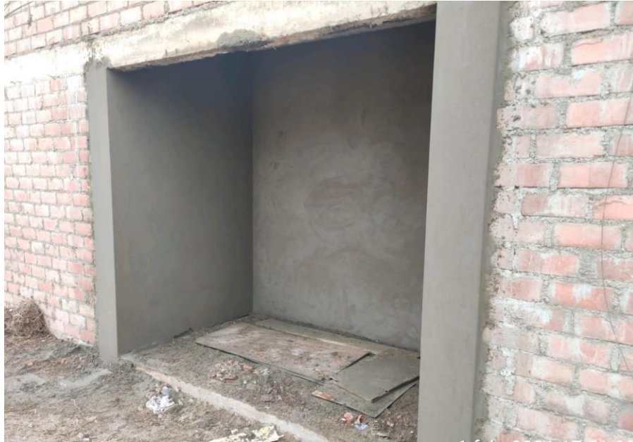
Figura 3.8: Trabajos civiles - Caseta de la Estación de Filtración Primaria EFMP.
