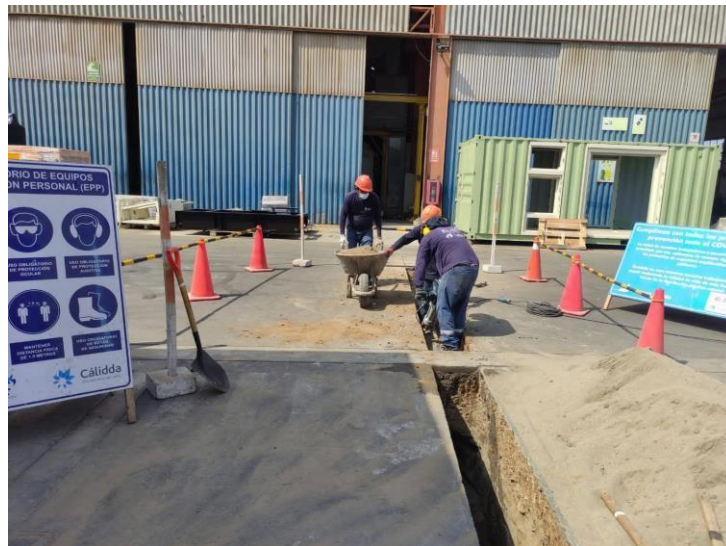
Figura 3.13: Excavación de zanja para la instalación de tubería HDPE - 2.
