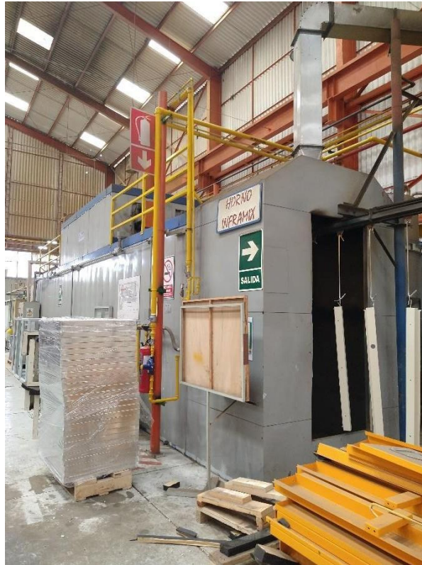
Figura 3.20: Red Interna de GN a línea de horneado Sifap - 2.
