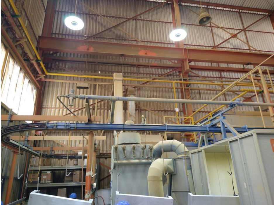
Figura 3.18: Red Interna de GN que recorre tijera y vigas de amarre.
