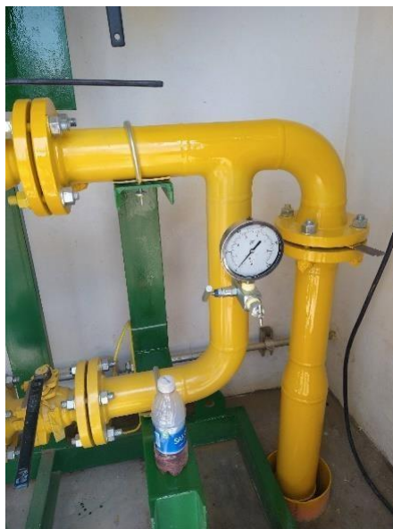
Figura 3.37: Prueba de hermeticidad en presencia de OSINERGMIN - 2.
