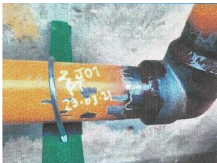
Figura 3.31: Prueba de tintes penetrantes a las uniones soldadas - 2.
