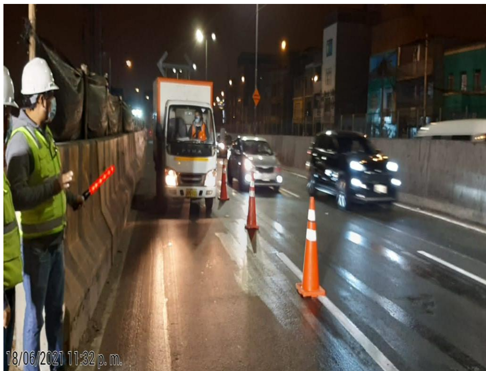
Vehículo de contención en la vía evitamiento, para los trabajos nocturnos
