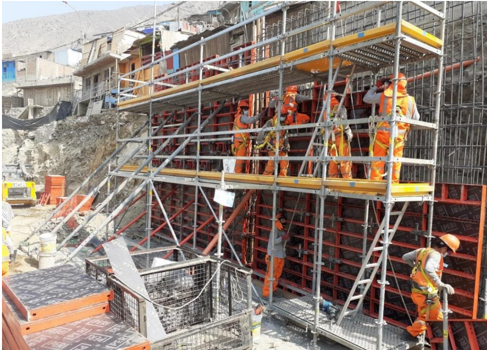
Trabajos de alto riesgo, trabajos en altura sobre andamios
